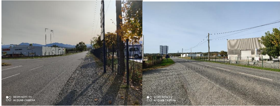
Figure 9 Route de l'ancien Circuit - Bon état mais pas d'aménagement modes actifs - Iter 2020
