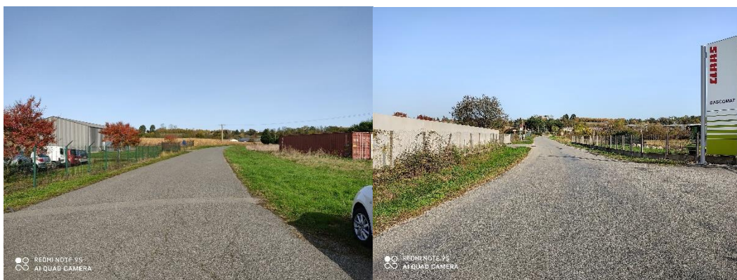
Figure 8 Chemin de la Graouade - Bon état - Iter 2020
