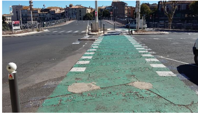
Figure 82 Marquage cyclable sur chaussée afin de marquer les traversées cyclables
