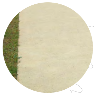
Voie verte en stabilisé
