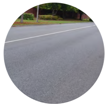
Chaussée en enrobé
