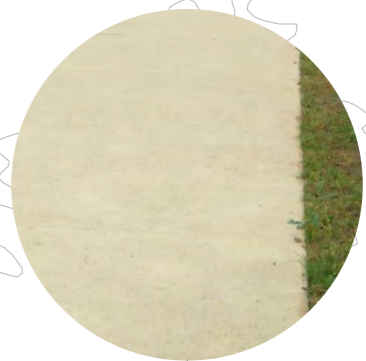
Trottoir en stabilisé
