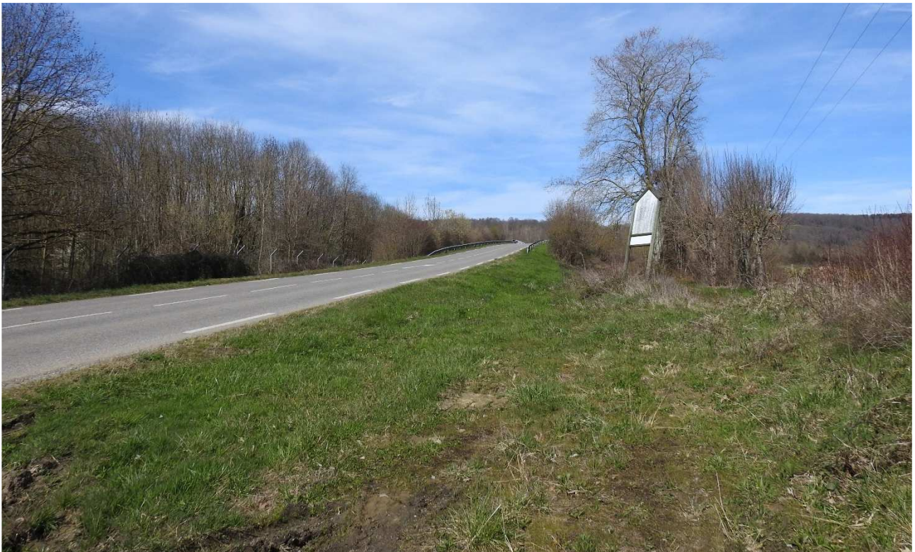
Figure 19 : RD633 bordant le site n°3 à l'ouest (photographie prise le 19/03/2025 - © SIRE Conseil)
