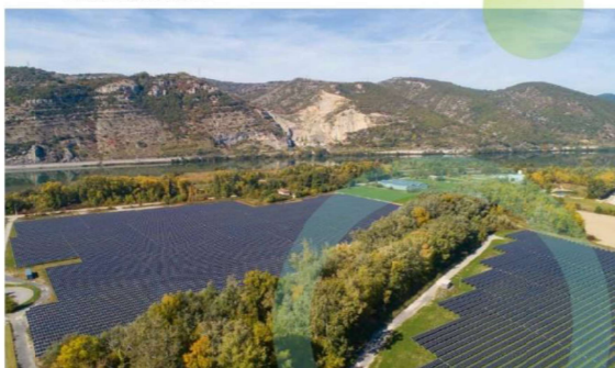
Parc photovoltaïque Le Pouzin 2 (07)
