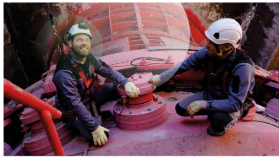
Innovation CNR : posture d'assujettissement et film de sécurité pour opération de maintenance
