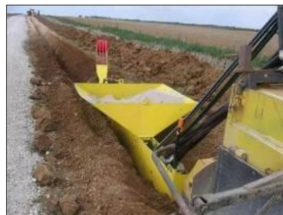
Photo 7 : Engin utilisé pour le creusement de la tranchée et la pose des câbles
