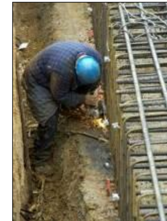
Photo 11 : Préparation des fondations
