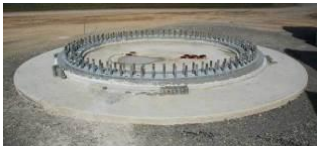
Photo 2 : La fondation terminée
