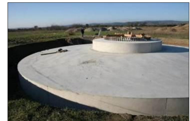
Photo 14 : La fondation terminée
