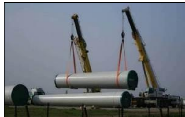
Photo 16 : Manipulation des tronçons d'éoliennes
