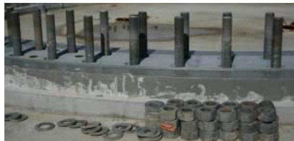
Photo 3 : Détail des fixations de la fondation
