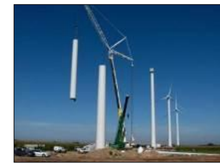
Photo 18 : Vue d'ensemble des étapes d'assemblage de la tour (exemple de tour en acier)
