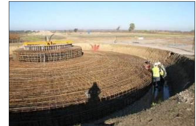
Photo 12 : Ferrailage de la fondation
