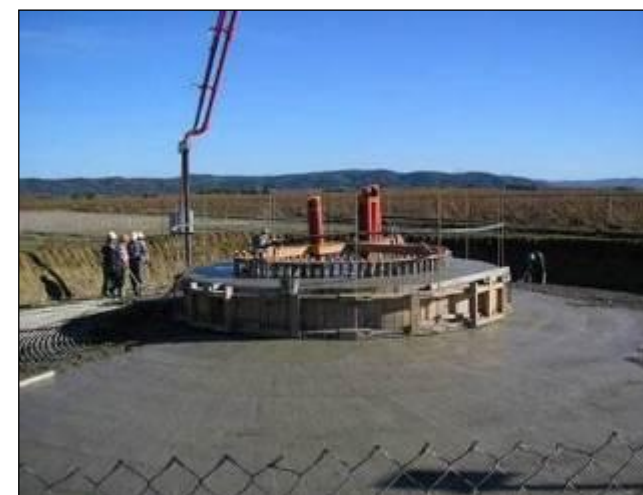
Photo 13 : Coulage du béton
