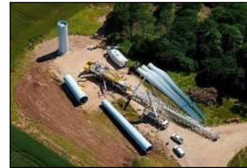
Photo 18 : Vue d'ensemble des étapes d'assemblage de la tour (exemple de tour en acier)
