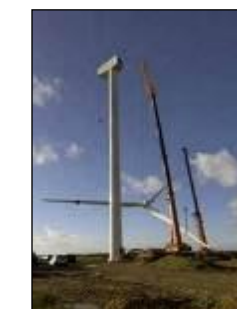
Photo 20 : Hisse et assemblage du rotor
