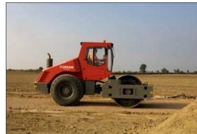
Photo 5 : Aplanissement du terrain
