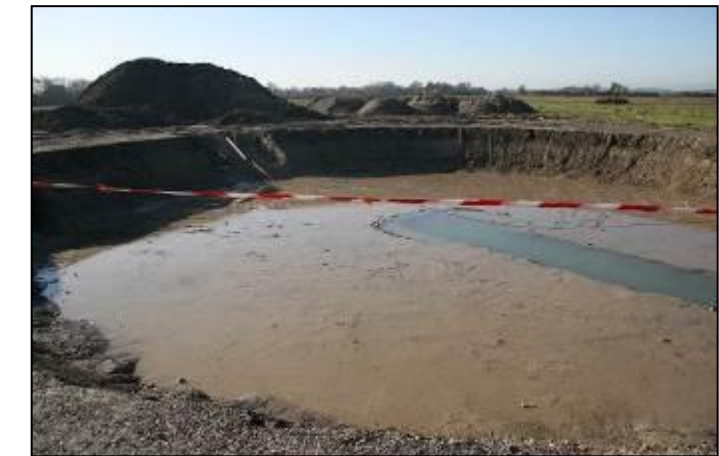
Photo 9 : Fouille de la fondation
