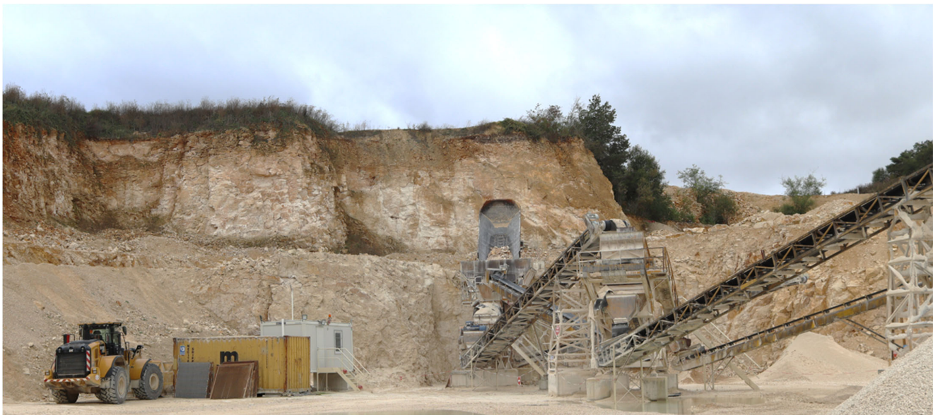
Vue générale de l'installation de traitement
