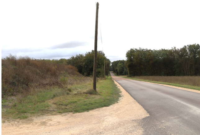
Route départementale D6 au niveau de la sortie de la carrière
