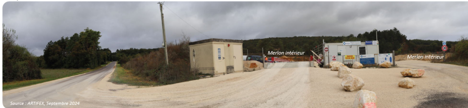
1 - D6, entrée dans la carrière
