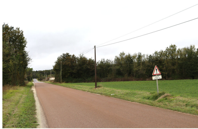
Signalisation de la carrière sur la route départementale D6
