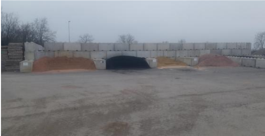
Photographie 7 : Exemple de blocs casiers (Source : TPFC)
