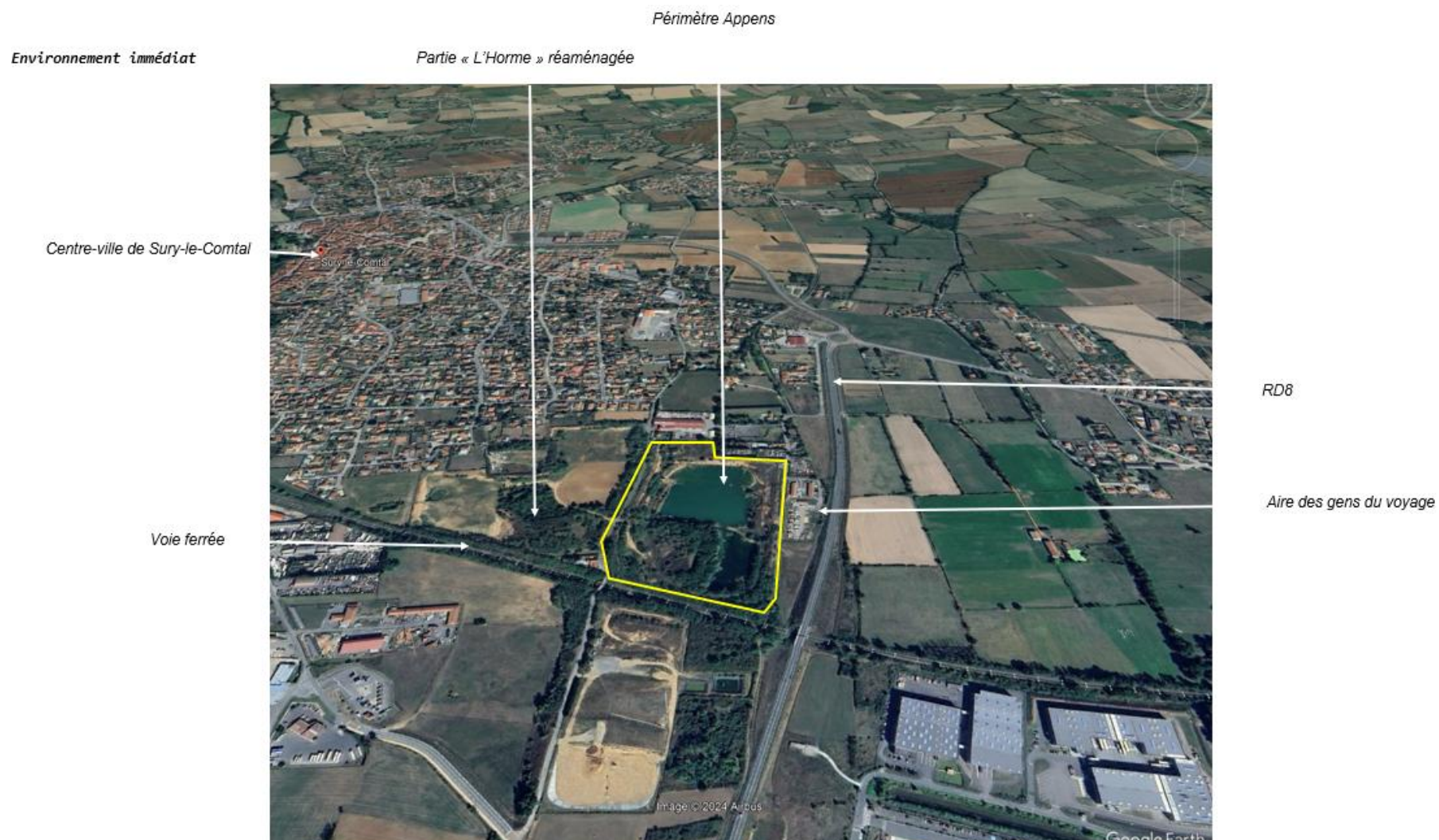
Figure 7 : Vue du site
