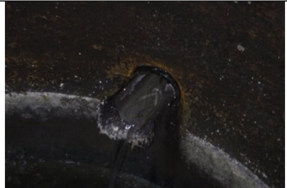
Racines et infiltration autour de l'arrivée PR Planginot La Brée-Les-Bains (Petits Marais)
