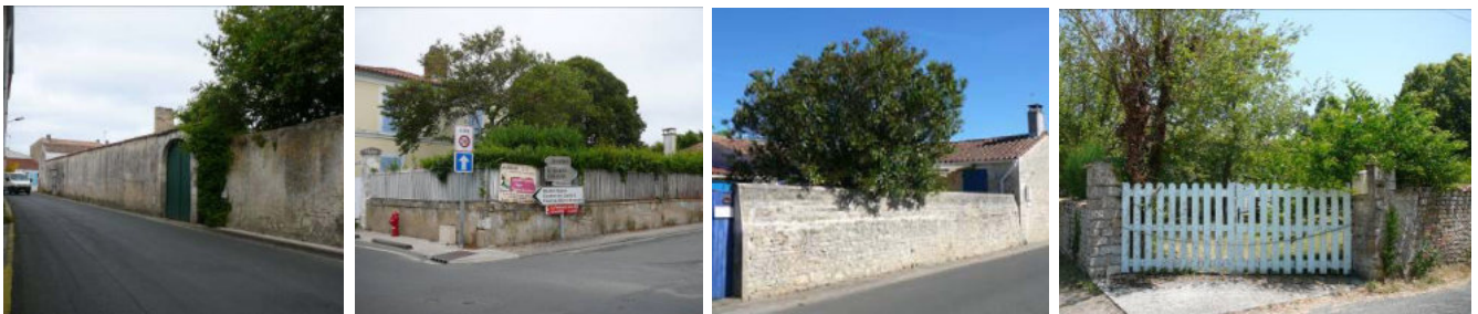
■ Clôtures à conserver
