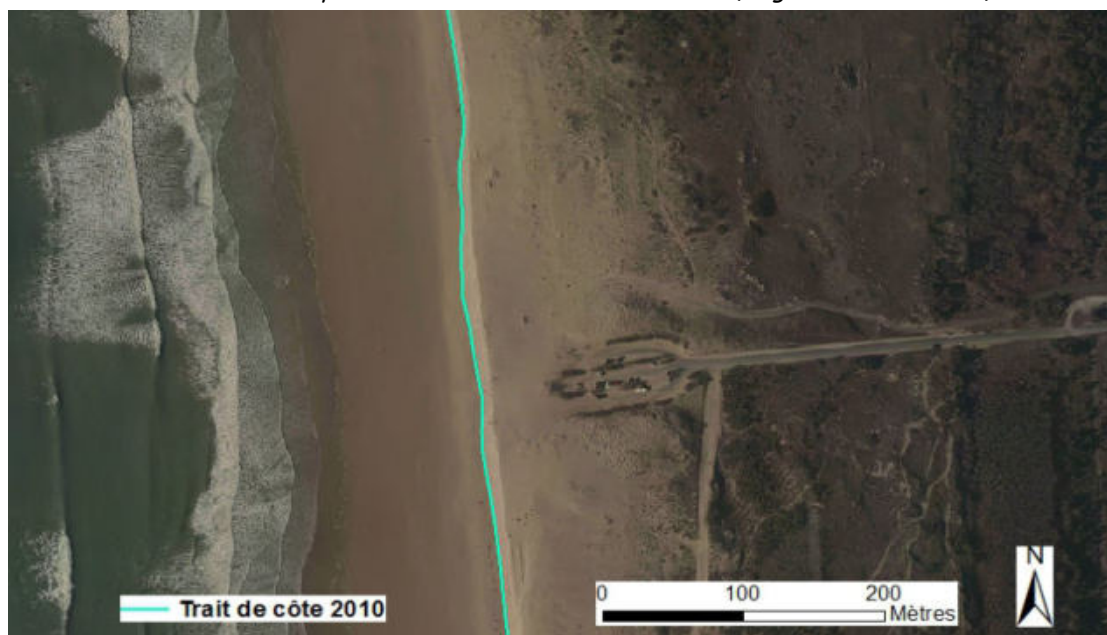
Numérisation du pied de dune sur les côtes sableuses (Plage de la Giraudière)
