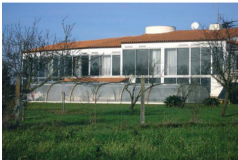
Serre climatique en façade sud, Bourcefranc
