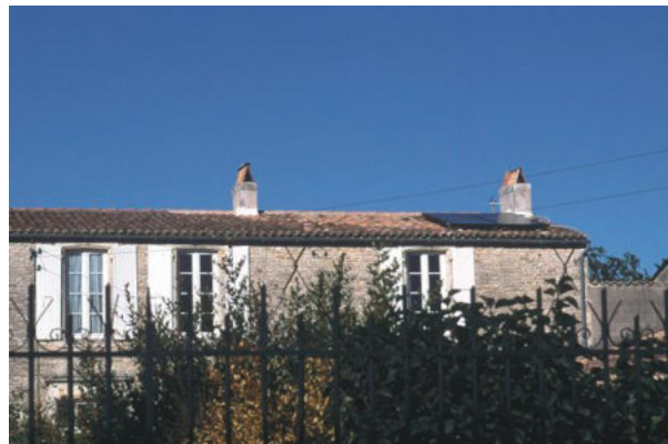
Capteurs solaires sur toiture ancienne
