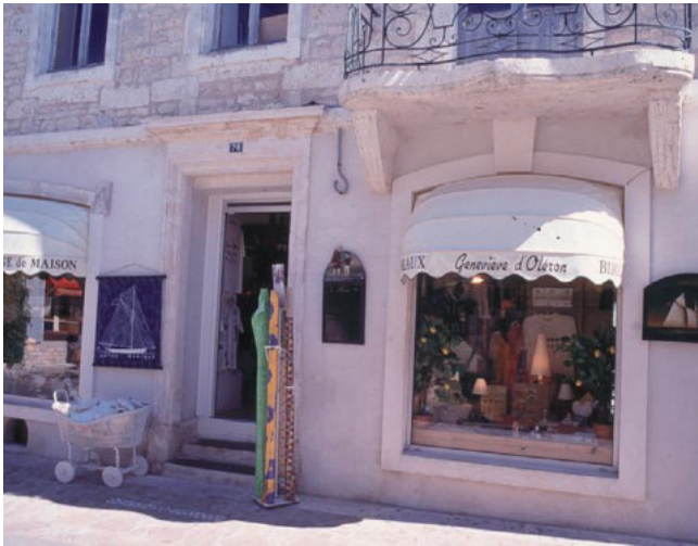
Les vitrines ont conservé les modénatures de la façade d'origine, Saint-Pierre d'Oléron
