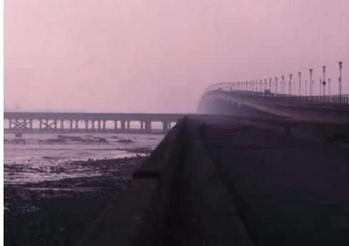
En 1966, le Conseil Général réalise le viaduc qui accueille un trafic en pointe de 15000 véhicules/jour en moyenne (2005).
