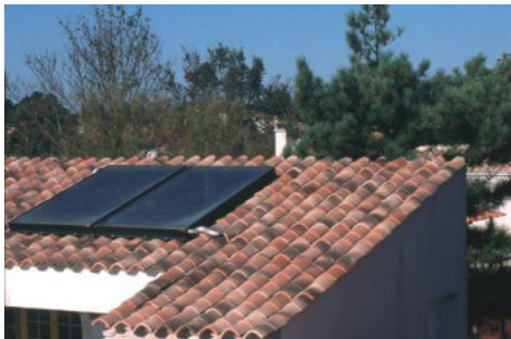
Capteurs solaires intégrés sur toiture neuve, Chéray
