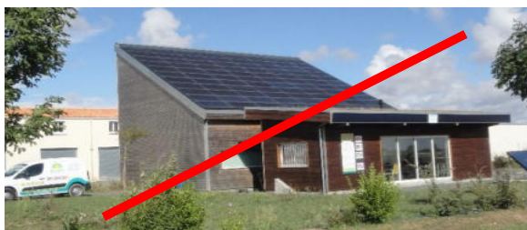
La pente de cette toiture solaire est trop prononcée
