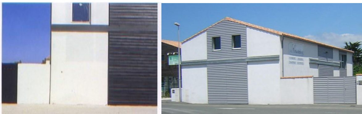
Exemples de complémentarités entre maçonnerie traditionnelle et bardages bois peints.
