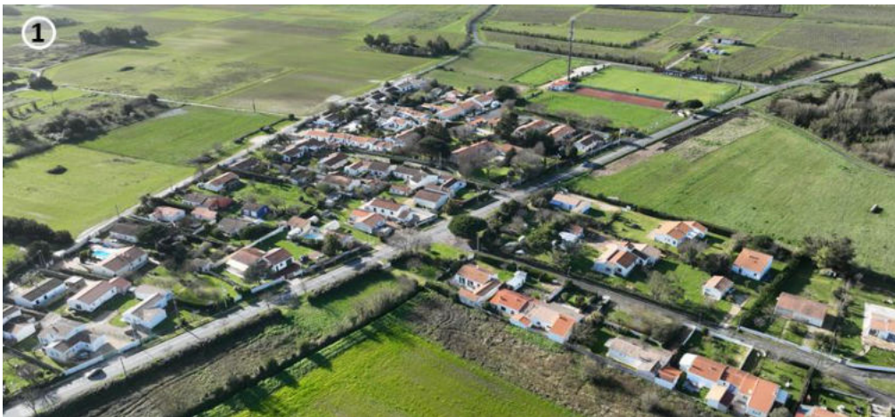
(1) Nord Chéray, absence de bande boisée significative au droit des EBC
