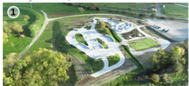
Skate park réaménagé, après travaux (photo : commune de Saint-Georges-d'Oléron, 2025)
