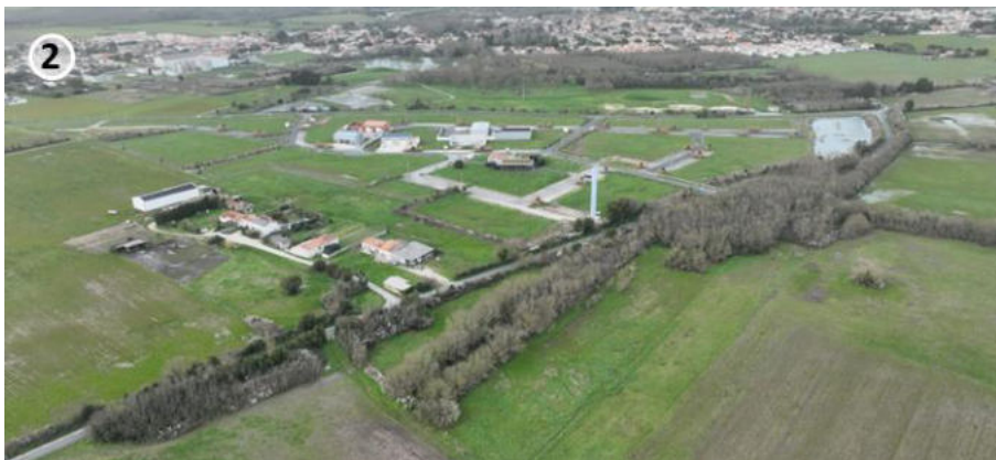
Vue aérienne de la continuité écologique entre les Prés Valet (en arrière-plan) et le boisement classé en EBC Rue des Quatre Moulins Photo drone, commune de Saint-Georges-d'Oléron, 2024
