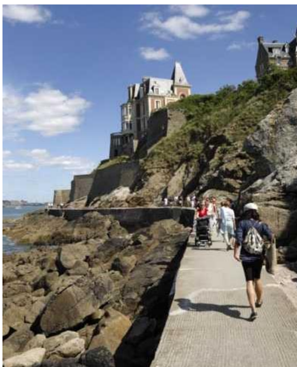
Figure 51 : Chemin des douaniers aménagé au niveau de collecteur du système d'assainissement (source : ville de Dinard)
