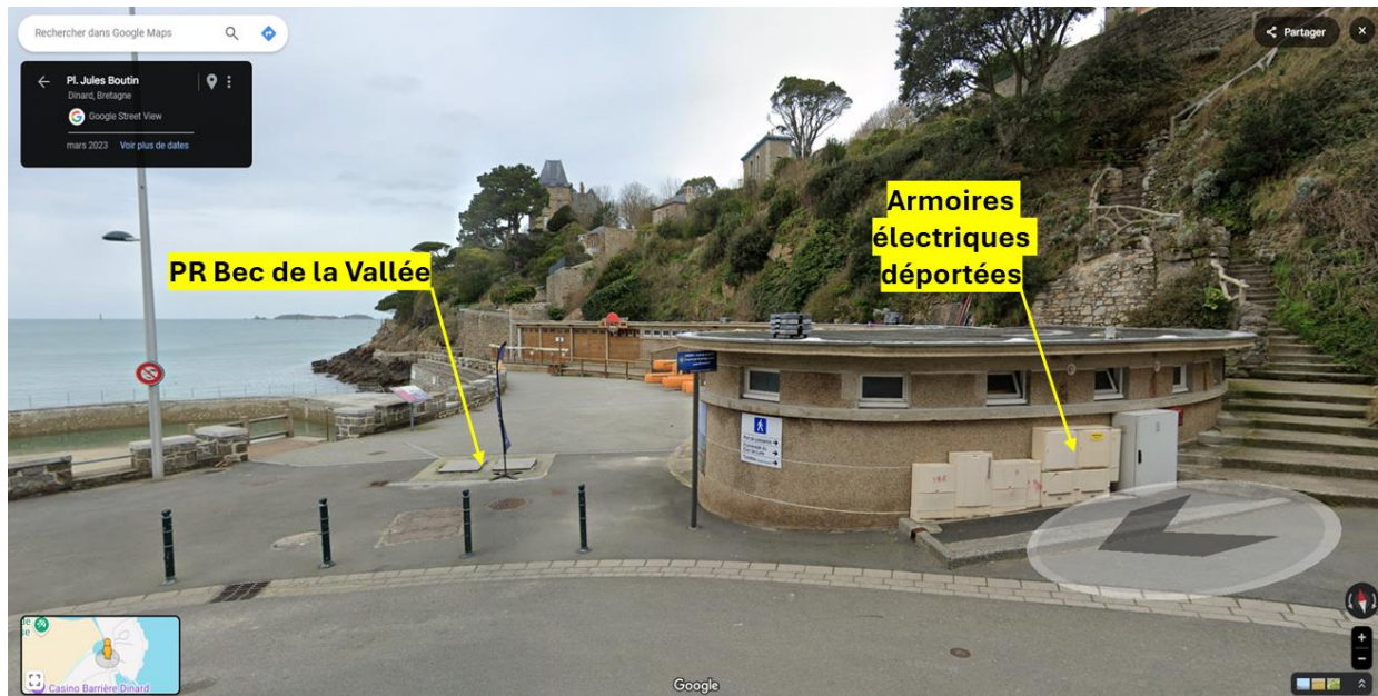
Exemple de dispositions déjà réalisées pour protéger les ouvrages en cas de submersion marine (cas du Pr du Bec de la Vallée) – (source : photo Google Earth)
