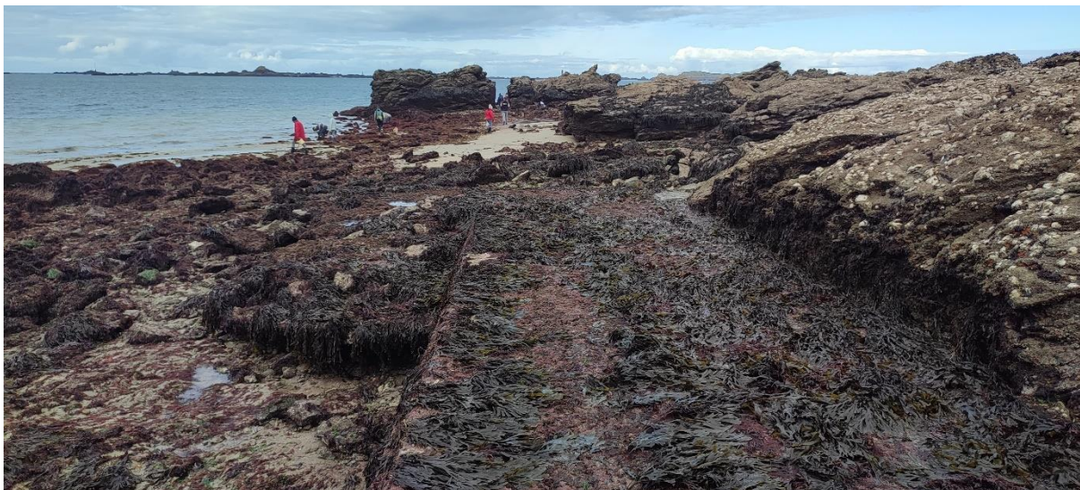
Figure 55 : Emissaire de rejet pluvial– Port-Blanc
