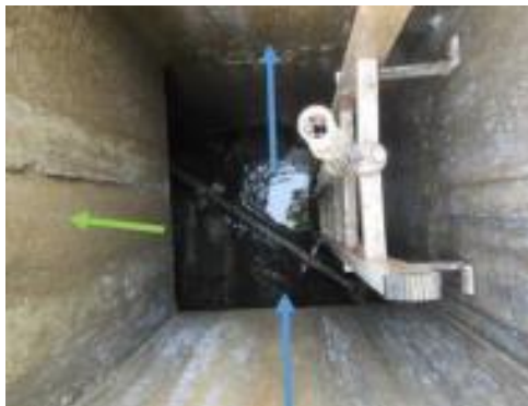
Figure 20 : Prise de de l'ouvrage à modifier rue Roger Vercel
