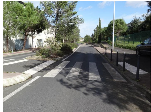
Avenue de Rome au Nord du site
