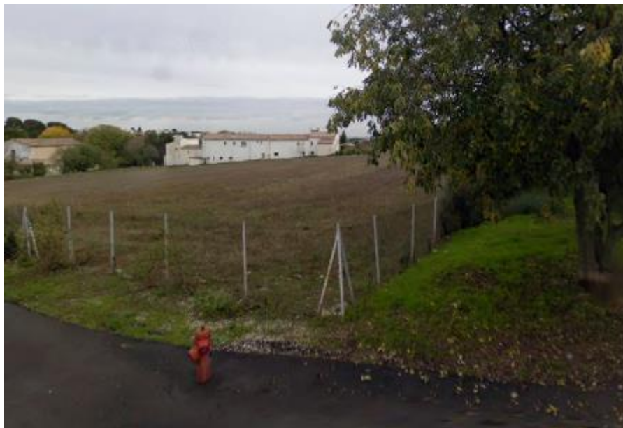
Poteau incendie en bordure immédiate de la ZAC (source : Google)
