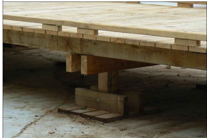
Référence de poteau posé sur une palée
