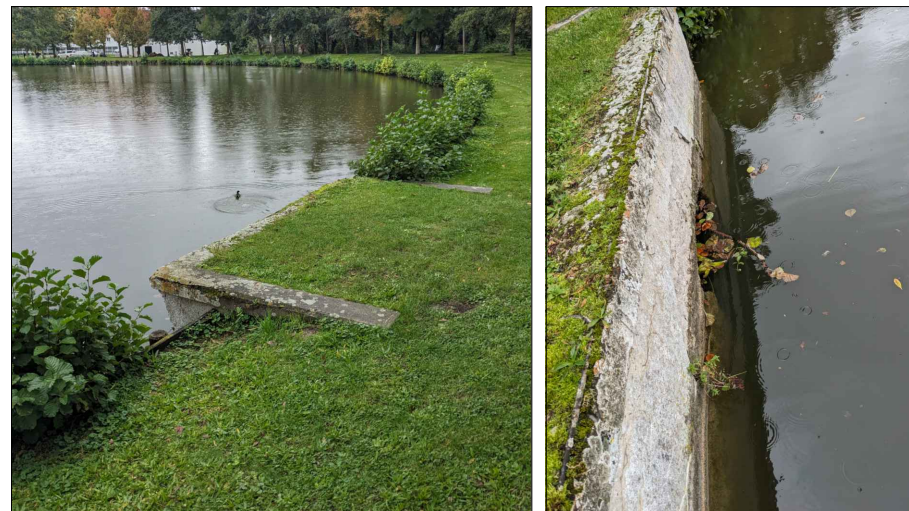
Vues sur le bassin et le déversoir
