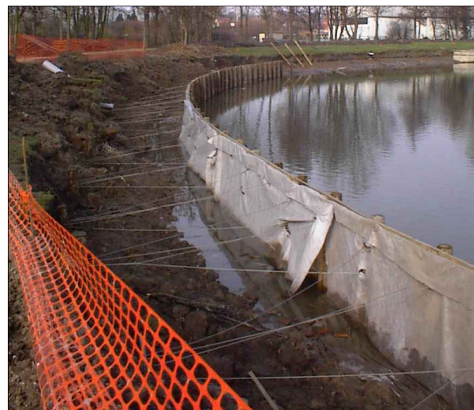
Photos de la mise en place du maintien de la berge (2001) / ouvrage en interface avec le ponton projeté
