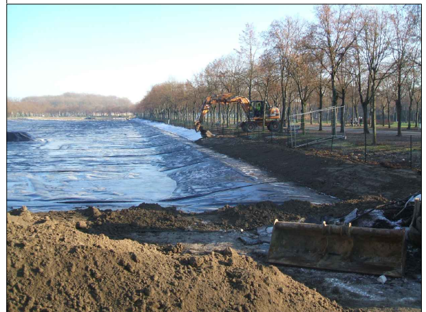
Photos sur le chantier de pose de l'étanchéité du bassin (2013)
