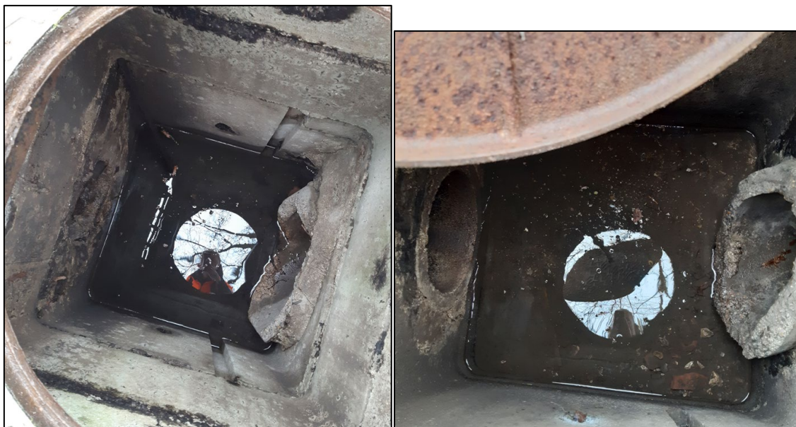
Avaloirs allée du 51 ème rue I
