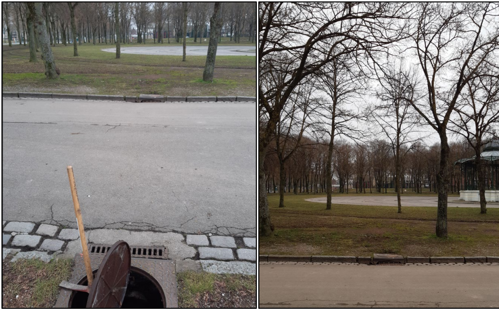
Avaloirs allée du 51 ème rue I
