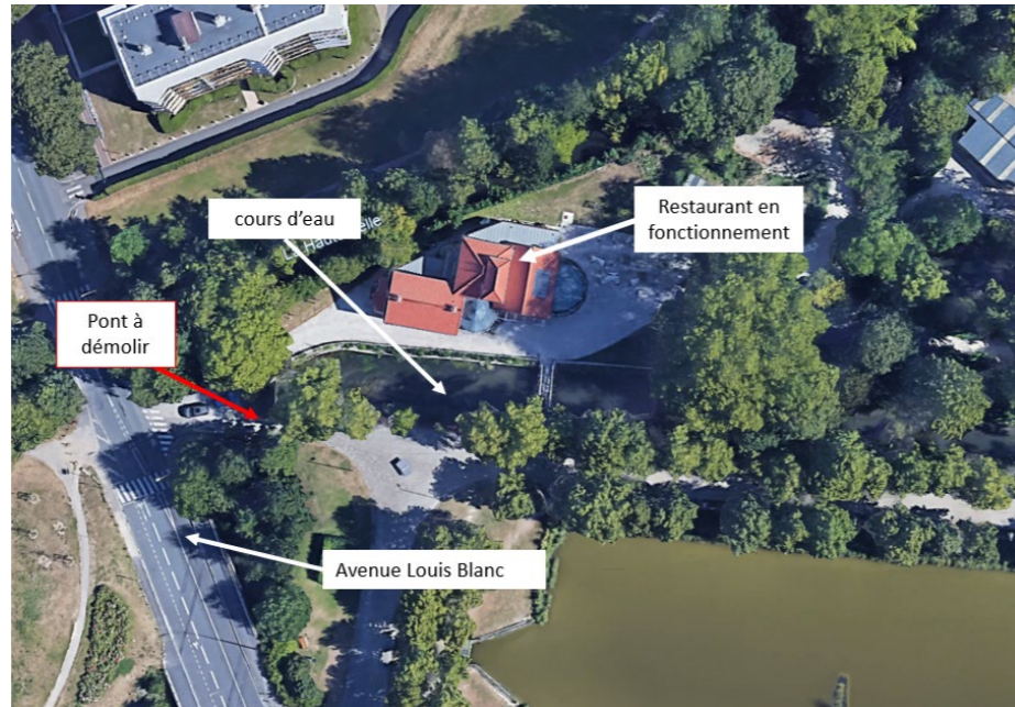
Vue aérienne des environs du pont à démolir et environnement immédiat des travaux de démolition
