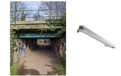
RAIL LED ÉCLAIRAGE SOUS PASSAGES VOIE SNCF
