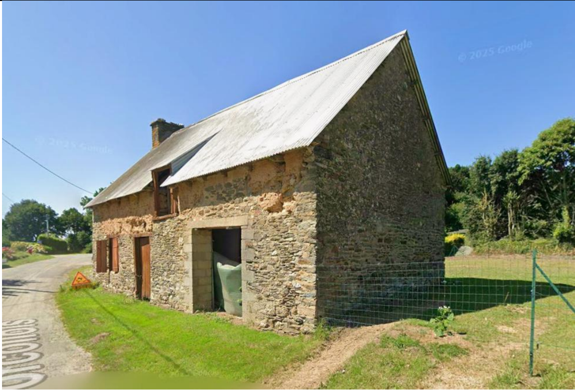
Bâtiment à identifier sur la parcelle 241 A 126
