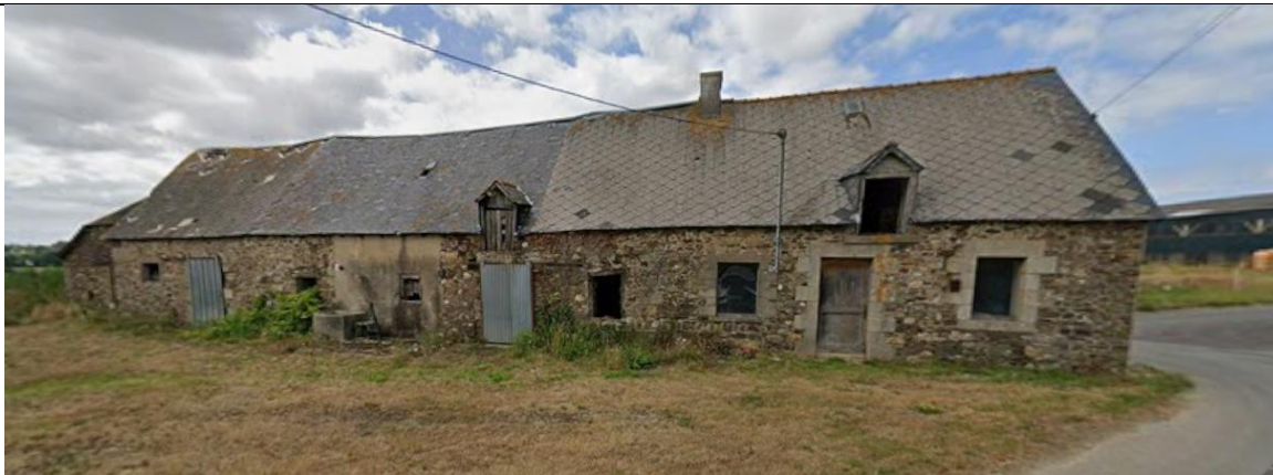
Photo des bâtiments identifiés comme pouvant changer de destination au PLUI en vigueur
