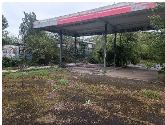
Figure 71 : Ancienne station-service au droit de l'aire d'étude immédiate (Crédit photo : THEMA environnement)
