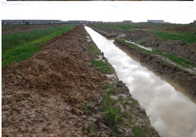
Excès d'eau observés dans les tranchées destinées aux investigations archéologiques (source : FLOW-concept, 30/12/2021)
