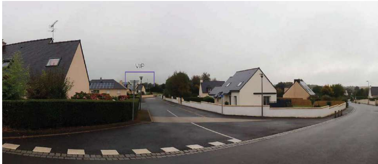
Le VIP est visible selon une prégnance significative depuis la frange nord de Plénée-Jugon (Source : agence Couasnon)
