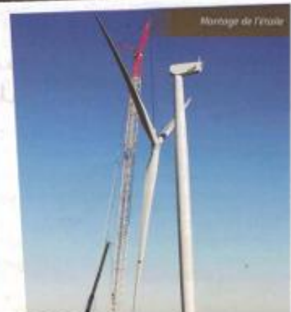
Montage des mâtures
