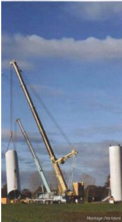
Montage d'une tour
