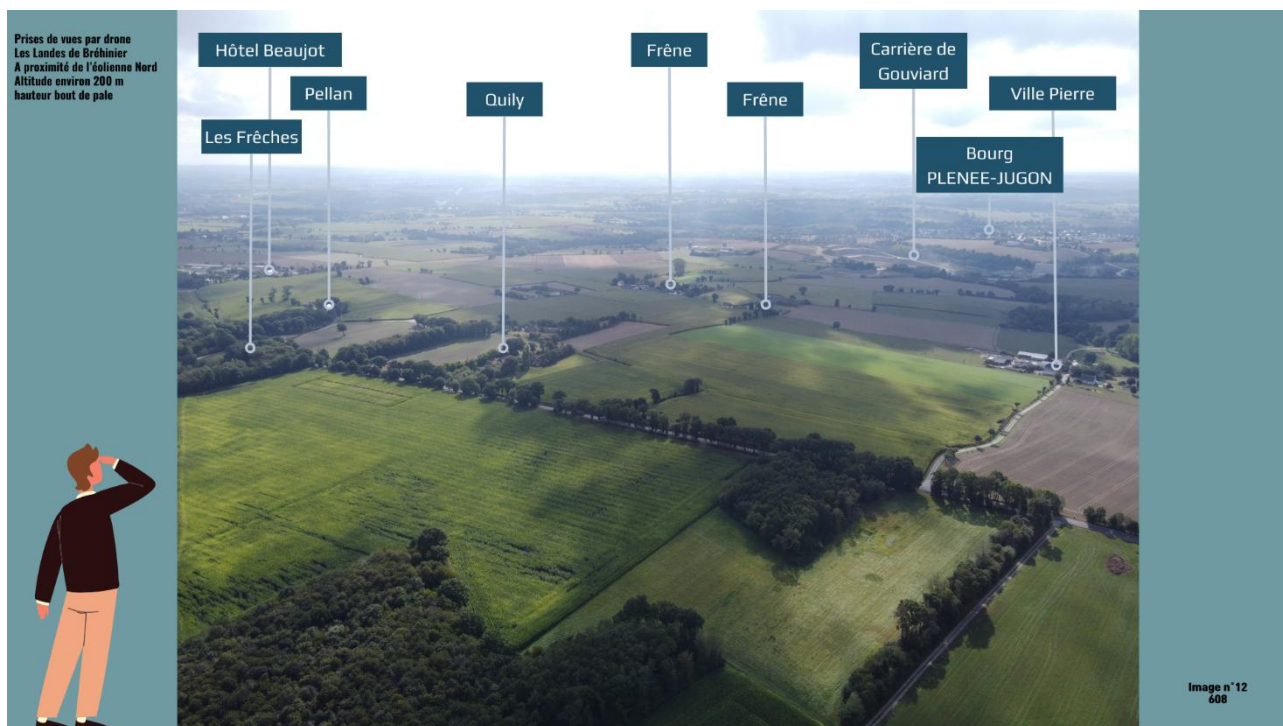
Prises de vue par drone, à proximité de l'éolienne Nord, Altitude environ 200m (hauteur bout de pale)
