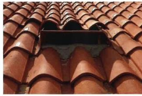
Réhabilitation de bâtiments anciens pour chauve-souris
