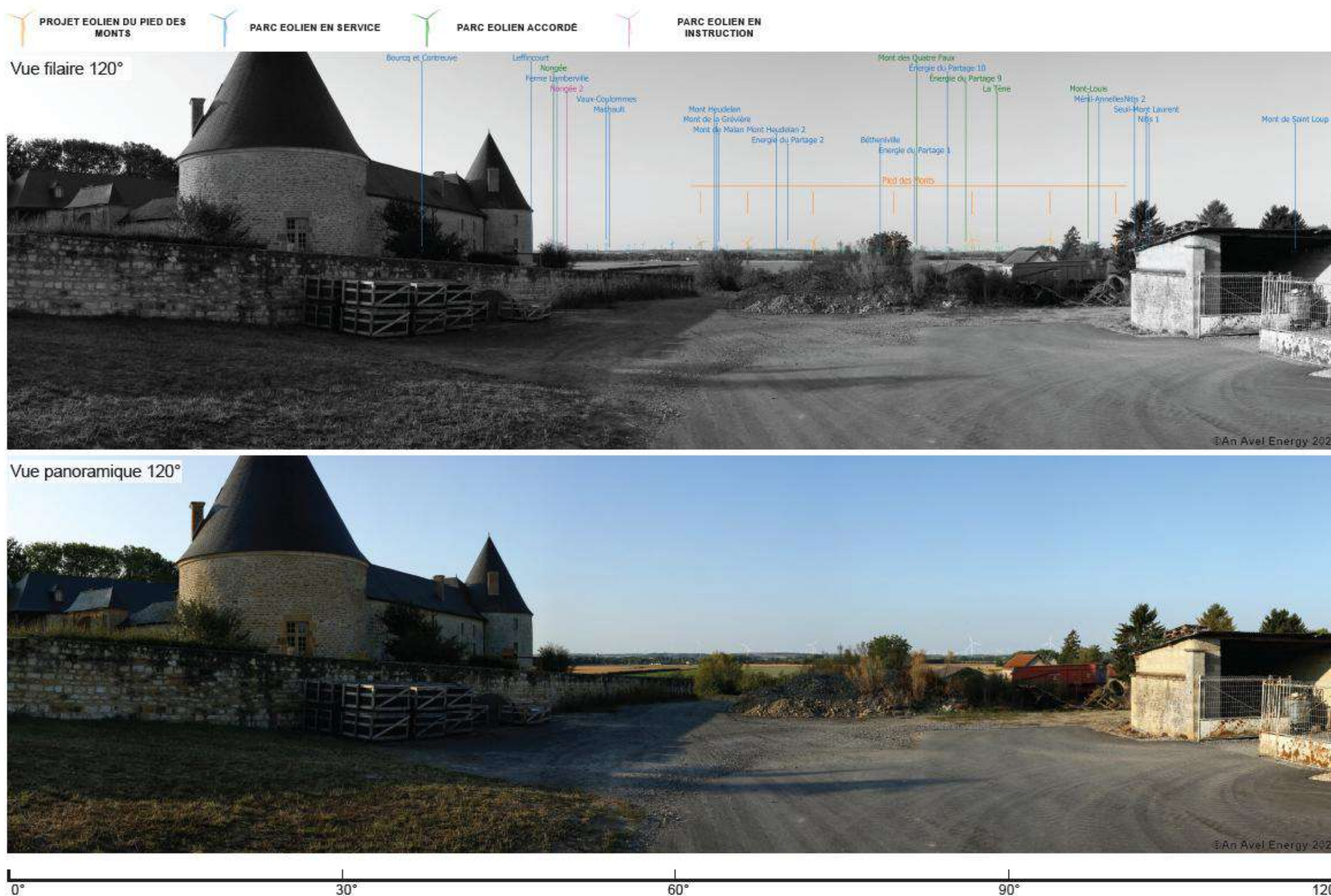
Figure 6 : Photomontage n°18 : vue depuis l'entrée du château de Charbogne 2/4 (source : An Avel Energy, 2022)
