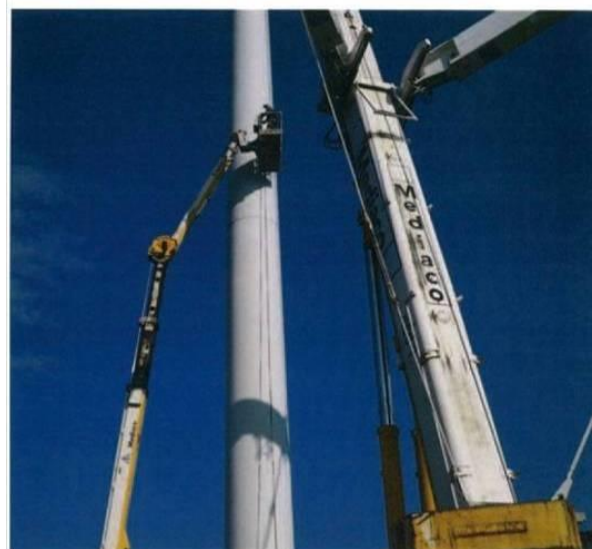
5 - Découpe pour dépose du premier tronçon du mât
