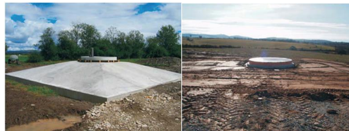
Photographie 4 : Massif béton terminé (à gauche), état final après remblaiement (à droite) (Source : EDF Renouvelables)
