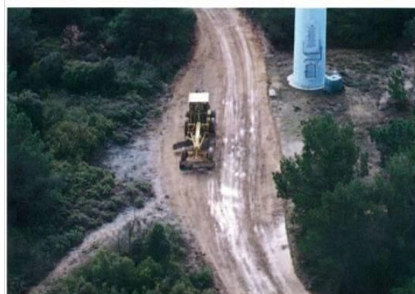
1 - Début des travaux et préparation des accès
