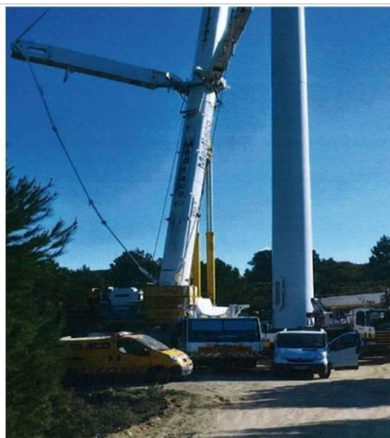
2 - Mise en place des engins de matutention (Grues, tracteurs et camions navettes) au pied de l'éolienne
