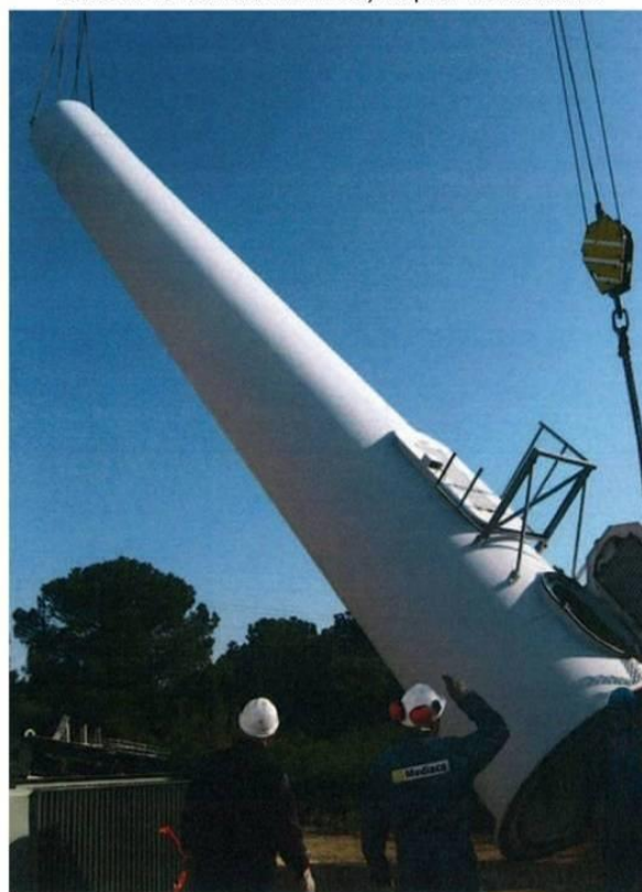
6 - Retournement avec la grue secondaire avec préparation et mise en place sur les camions navettes
