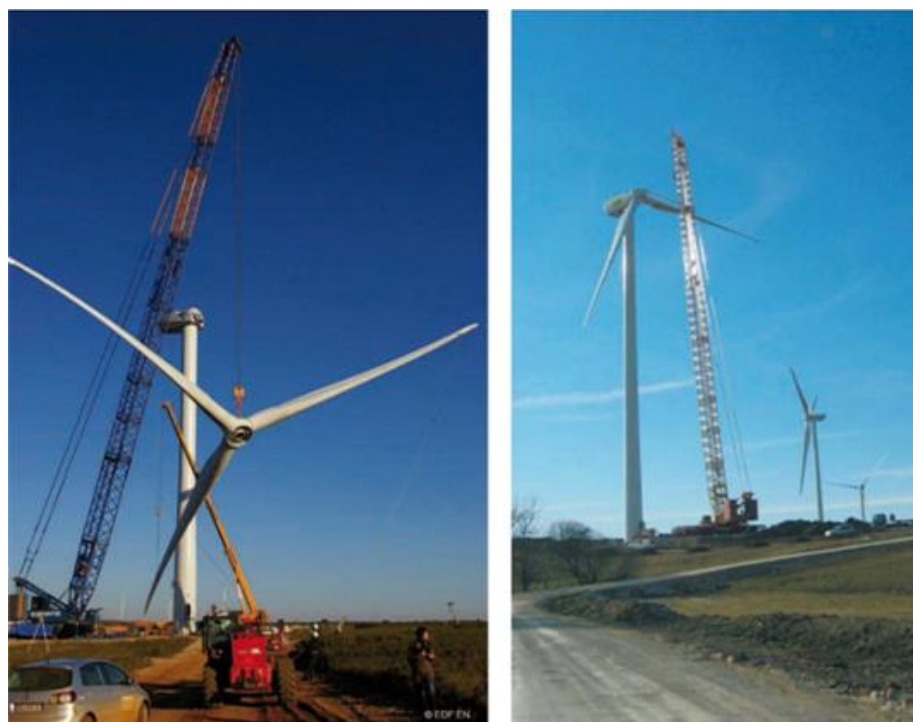
Photographie 6 : Montage du rotor (à gauche), montage « pale par pale » (à droite) (Source : EDF Renewables)
