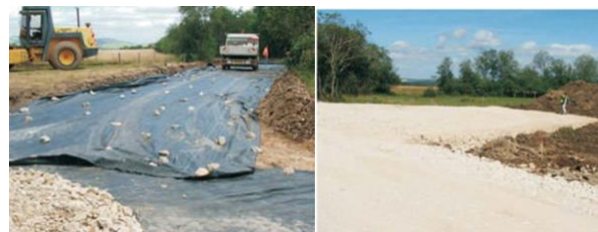
Photographie 5 : Pose d'un géotextile (à gauche), état final d'une plate-forme (à droite) (Source : EDF Renouvelables)
