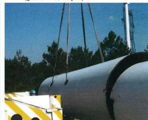
3 - Evacuation des composants de la nacelle (générateur, moyeu)
