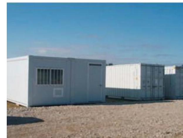
Photographie 1 : Installation de la base-vie (Source : EDF Renewables)
