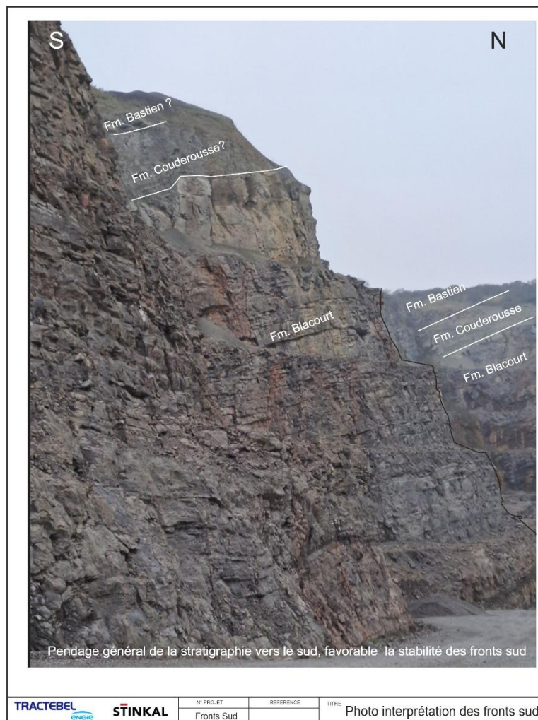
Figure 4 : Lithostratigraphie et structures des fronts sud. Orientation favorable à la stabilité. Ressource calcaire significative
