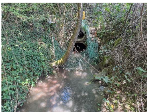
Photo 11 : Limite amont - buse de résurgence du cours d'eau après son passage dans la carrière
