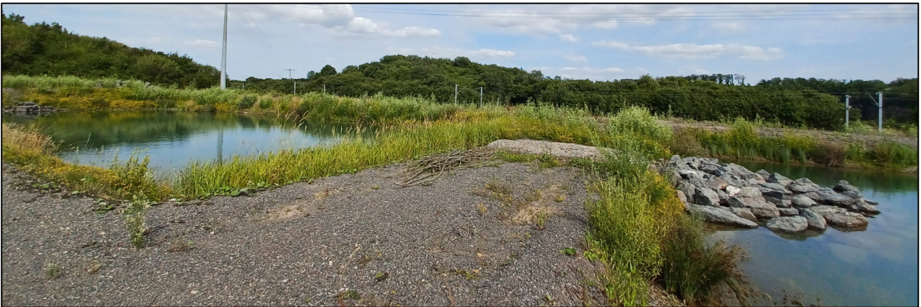
Photo 1. Bassins de décantation des eaux d'exhaure (eaux de nappe pompée en fond de fosse) de la carrière pouvant faire office de réserve d'eau incendie (source : Stinkal)
