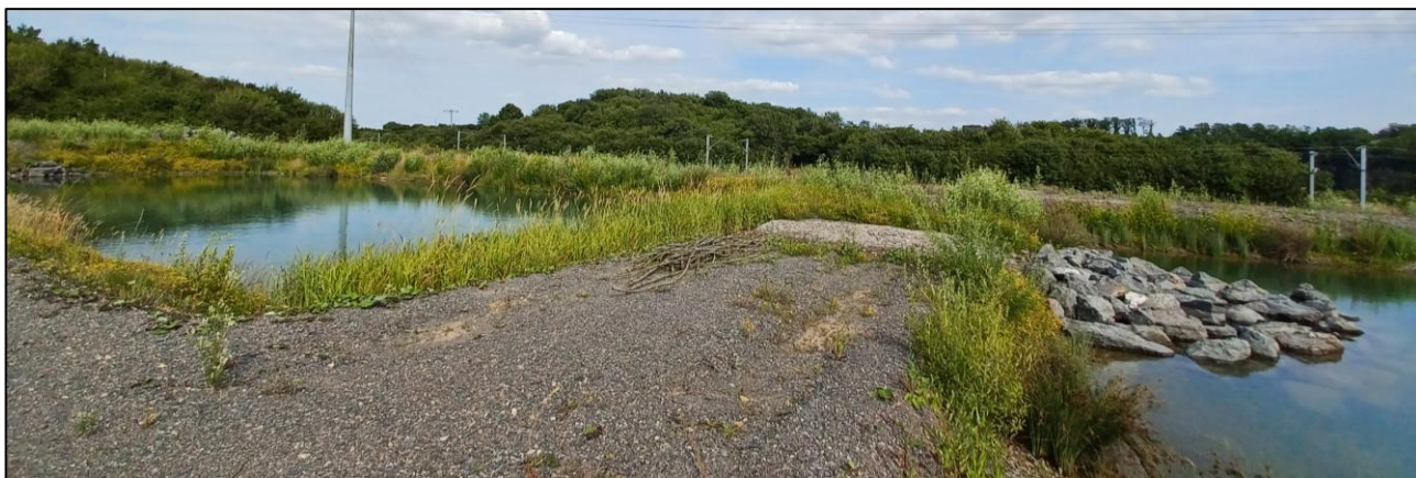
Photo 8. Bassins de décantation avec filtration naturelle et enrochement (source : Stinkal)
