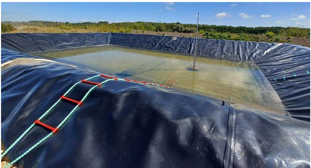
Figure 3 : Bassin étanche de récupération des lixiviats
