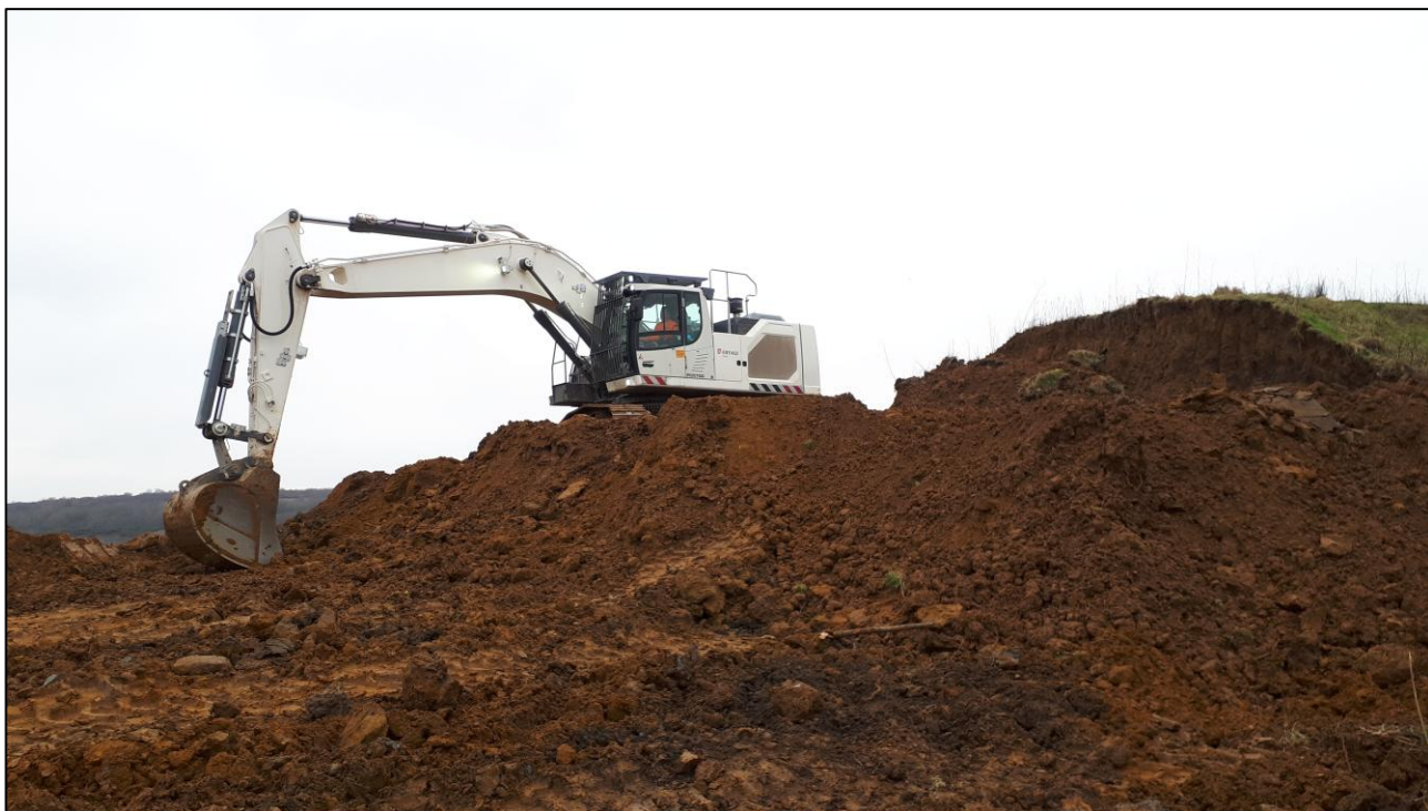
Photo 4. Terrassements de découverte (source : Stinkal)
