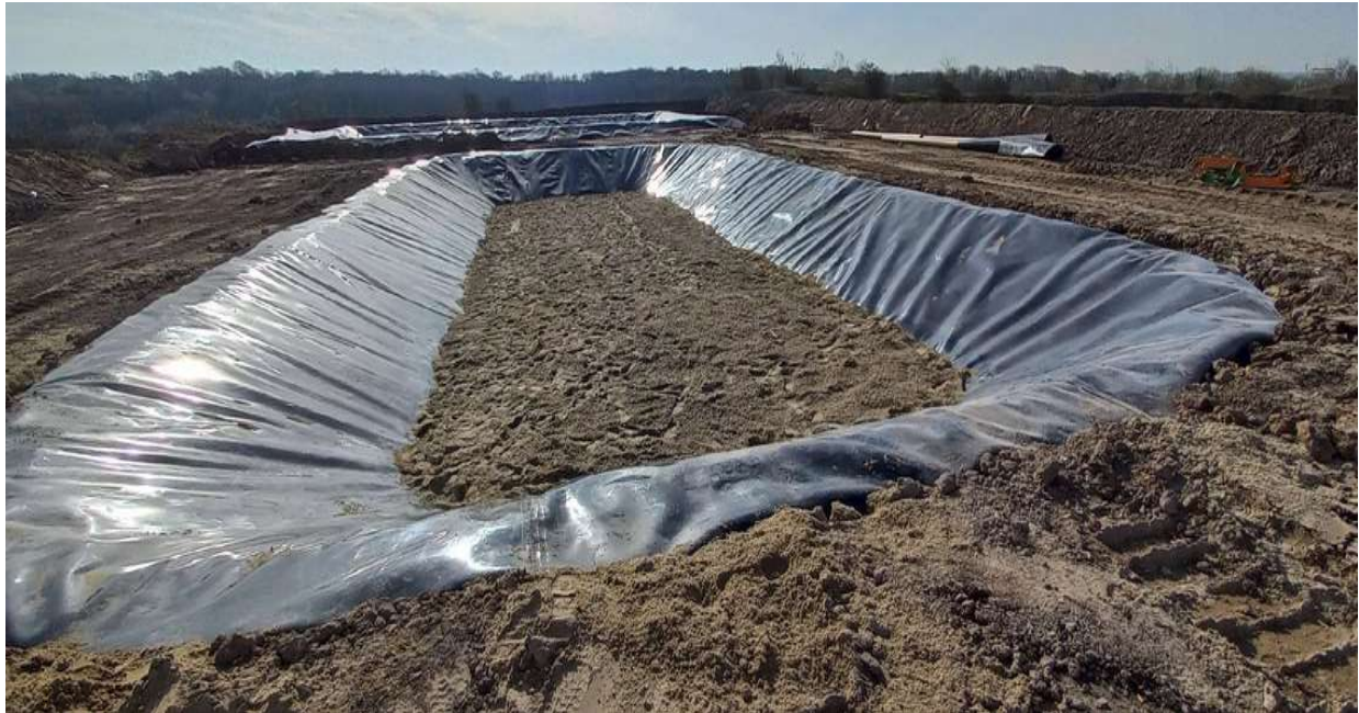
Figure 2 : Lagune étanche réalisée pour le pilote – avant l'arrivée des sédiments
