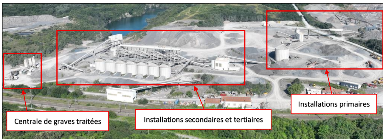
Photo 11. Vue d'ensemble des installations de production de granulats (source : Stinkal, 2025)
