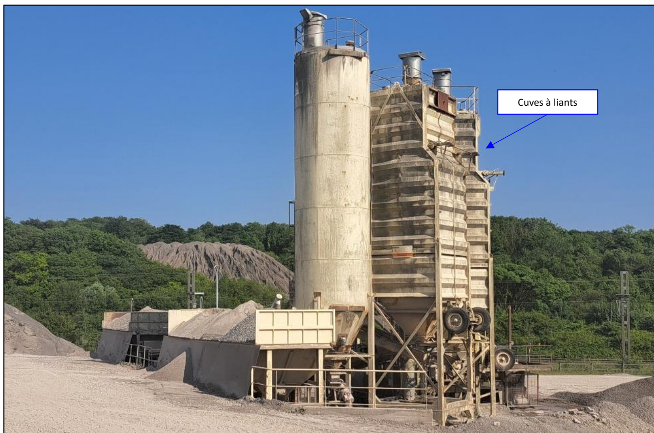
Photo 14. Centrale de fabrication de graves traitées (source : Stinkal, 2025)
