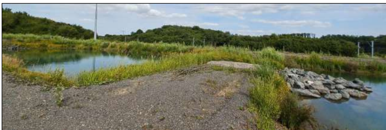
Photo 5. Bassins de décantation avec filtration naturelle et enrochement (source : Stinkal)
