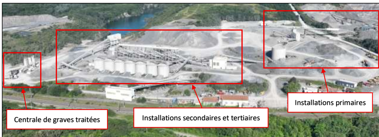
Photo 6. Vue d'ensemble des installations de production de granulats (source : Stinkal, 2025)
