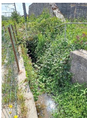
Photo 9 : Vue de la station depuis l'amont vers l'aval
