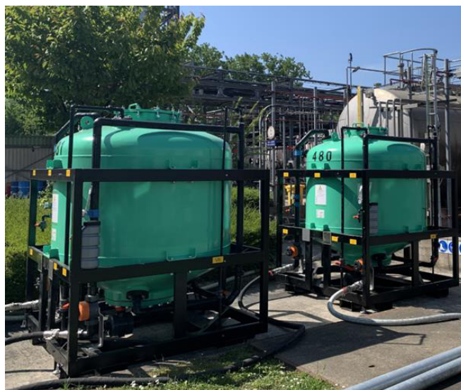
Figure 5 : Exemple de filtres de 2 m 3 (Desotec)
