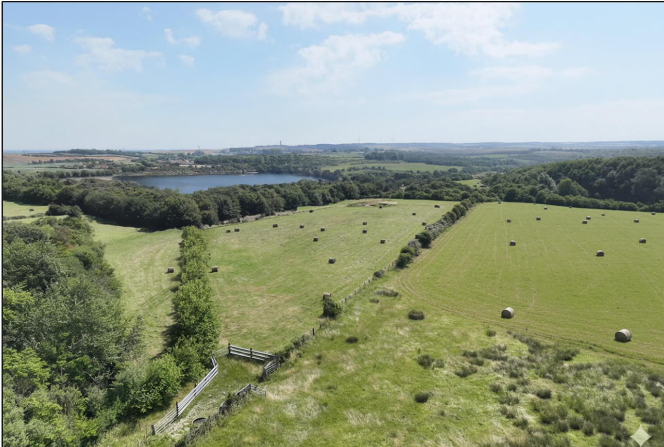
Figure 51. Remise en état du site (vue 2)
