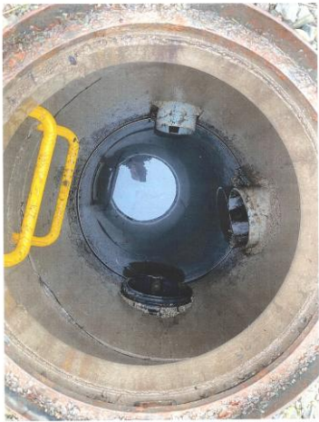
Vérification de la propreté des réseaux
