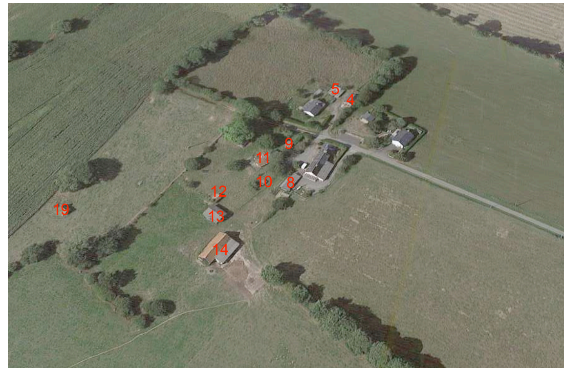
Photographie des bâtis légers de type hangars agricole ou ruines
