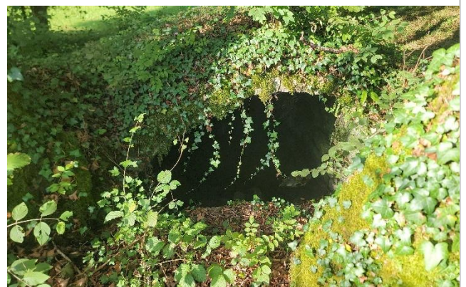
Cuve d'eau en pierre
