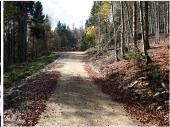
Route à camions grumiers
