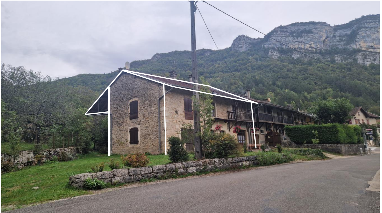
Une ancienne ferme réhabilitée à Chancia, composée de volumes simples
