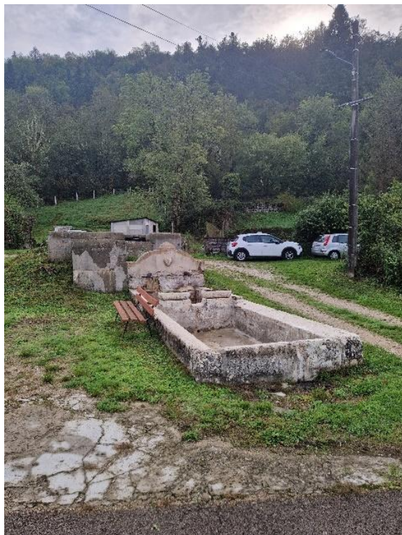
Ancien lavoir sur la commune de Lavancia-Epercy
