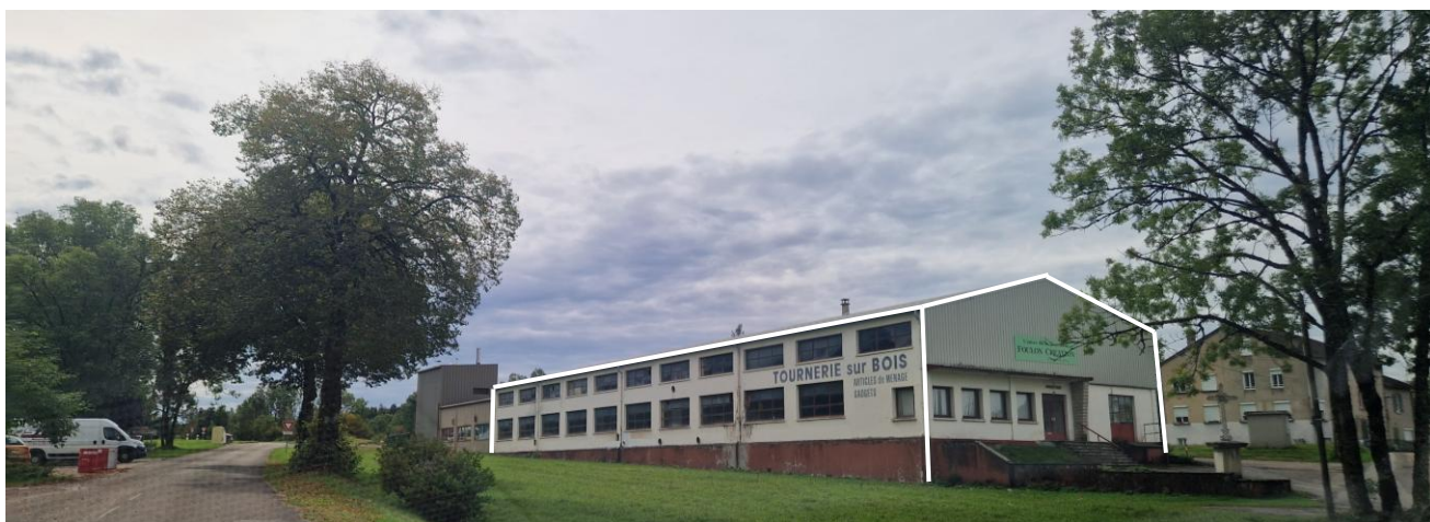
Un bâtiment industriel plus récent, composé de volumes simples
