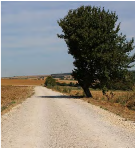
Exemple de chemin d'accès
