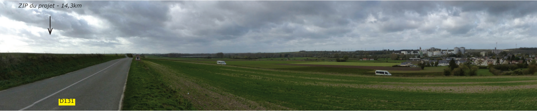
17 - Vue panoramique sur la ZIP depuis l'itinéraire de la D131, à la sortie sud de Origny-Sainte-Benoite
