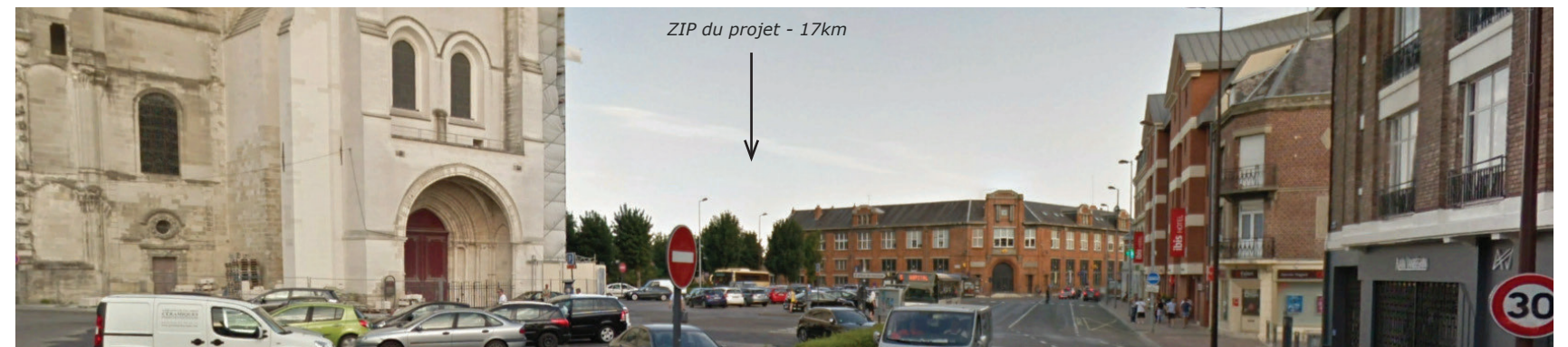
04 - Vue panoramique depuis les abords immédiats de la basilique de Saint-Quentin - source Google Street View
