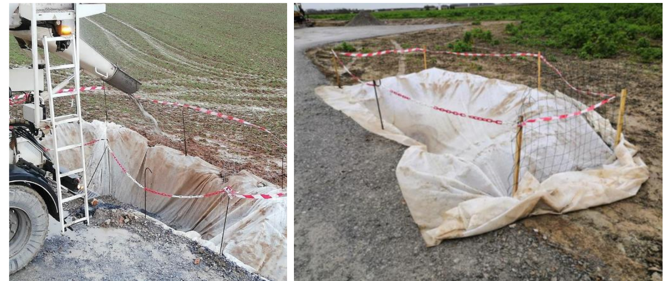
Figure 54 : Vérification des bonnes pratiques en phase chantier lors du coulage des machines
