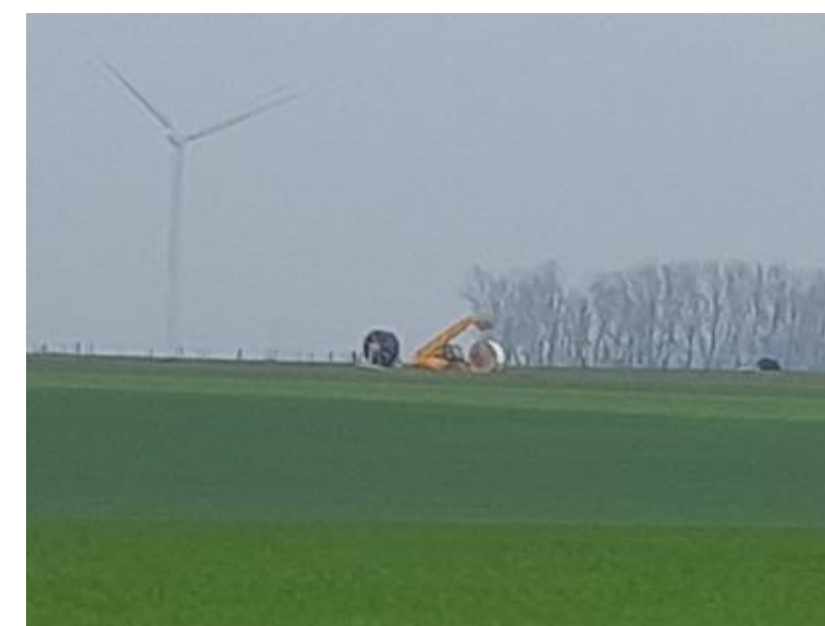
Figure 56 : Exemple de passage de câbles à la trancheuse
