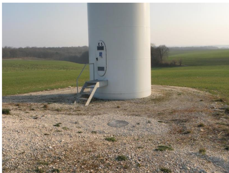
Figure 55 : Exemple de plateforme avec assainissement pour éviter la stagnation des eaux, un sol tassé et le développement de friches en pied d'éolienne
