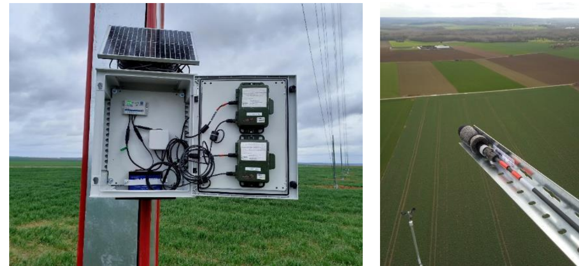
Figure 14 : Dispositif d'enregistrement installé sur un mât de mesure – T. Kestel - Ecosphère
