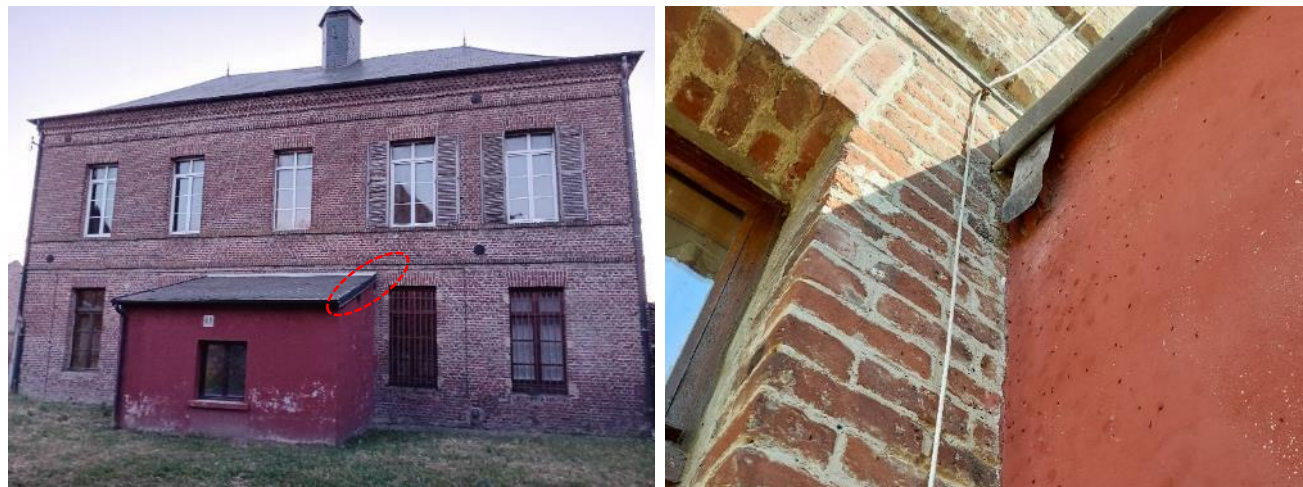
Figure 32. Bâtiment de la mairie de Mayot accueillant une colonie de parturition de Pipistrelle commune (accès au gîte entouré en rouge) - T. Kestel, Écosphère.
