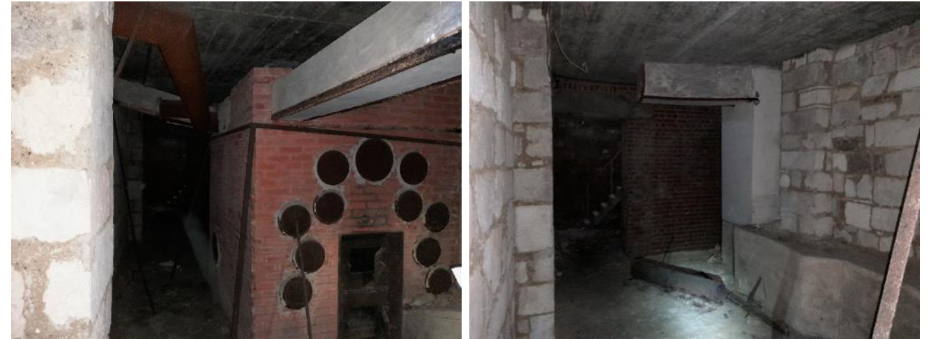
Figure 37. Sous-sol de l'église de Mayot - T. Kestel, Écosphère
