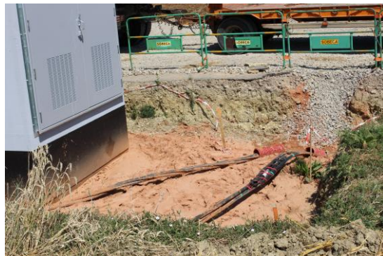
Photo 8 : Câbles souterrains reliant les éoliennes au poste de livraison avant enfouissement © Ora environnement
