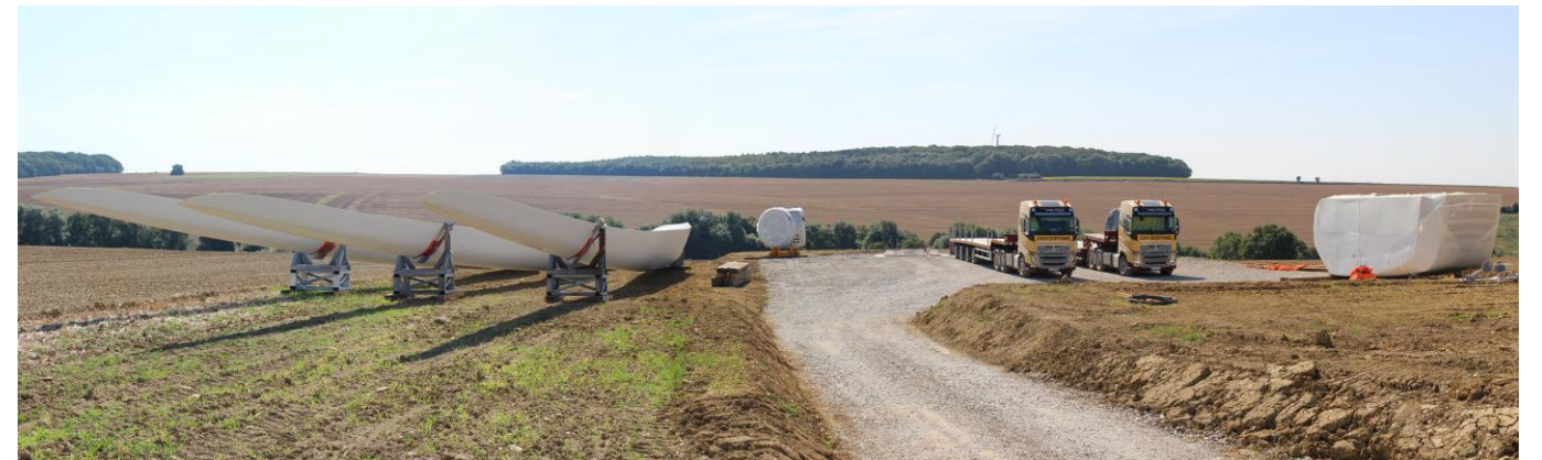
Photo 10 : Eléments d'éoliennes avant montage © Ora environnement
