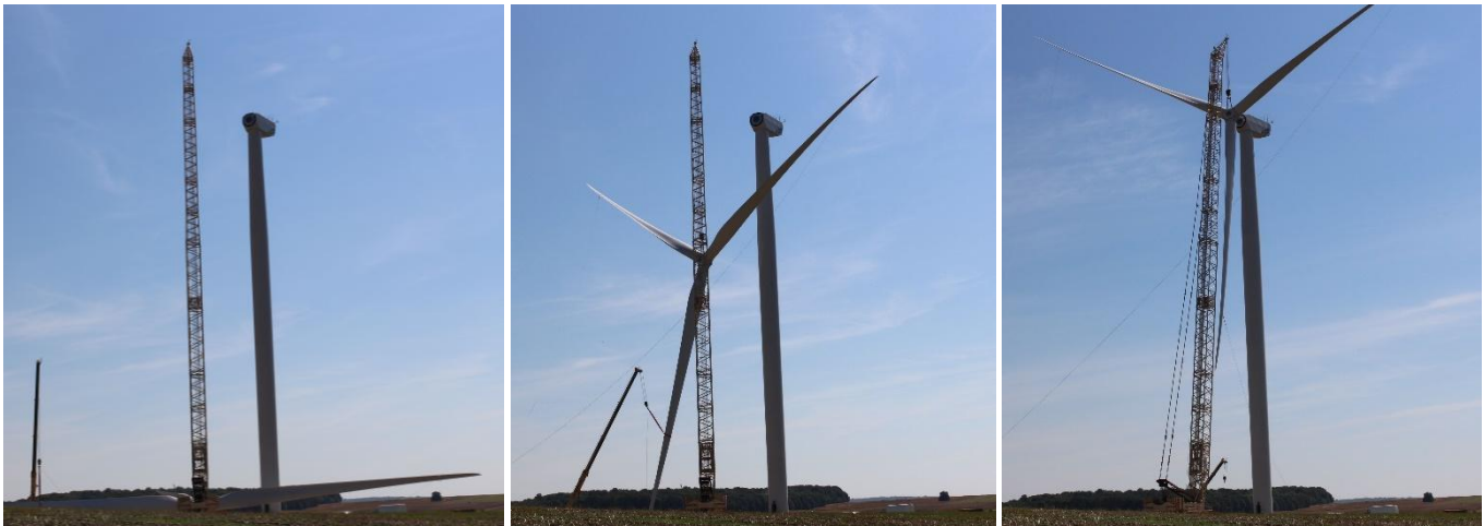
Photo 12 : Etapes du montage du rotor d'éolienne © Ora environnement
