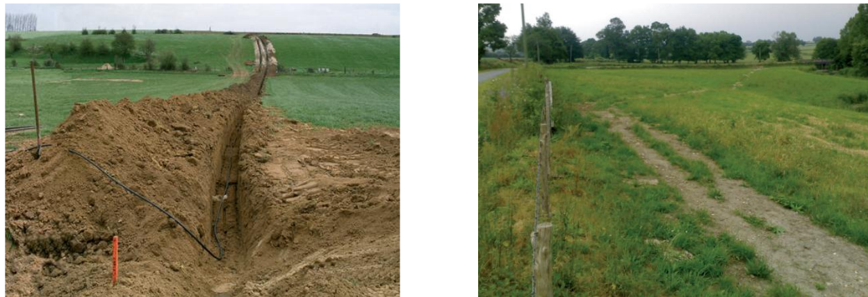
Photo 7 : Exemple de tranchée ouverte et de tranchée fermée depuis 2 mois
