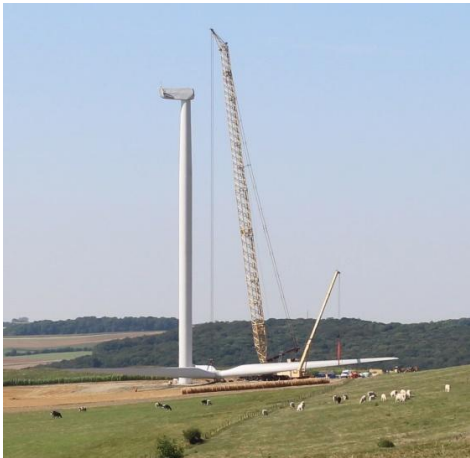
Photo 11 : Rotor assemblé au sol avant levage © Ora environnement
