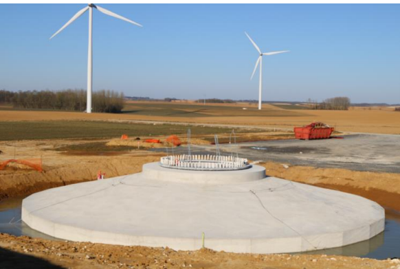
Photo 5 : Fondation avant recouvrement
