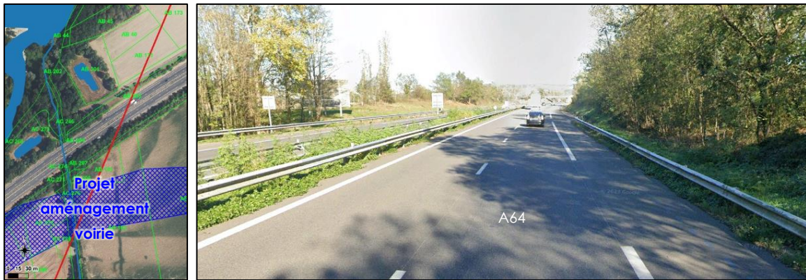
Figure 30 : Vue aérienne et photo de l'autoroute A64
