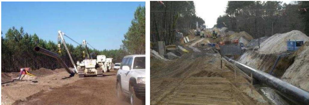
Figure 45 : Mise en fouille
