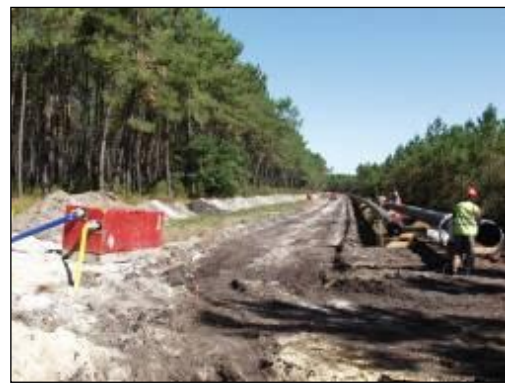
Figure 71 : Travaux de pose de la tranchée drainante et groupes de pompage
