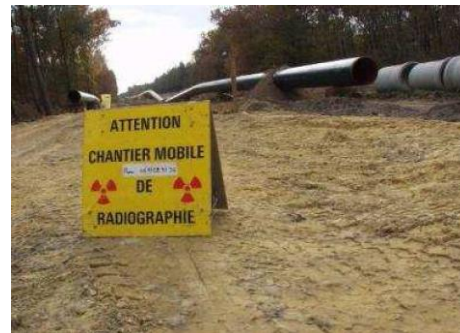
Contrôle des soudures par radiographie
