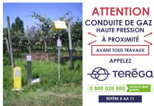
Figure 48 : Bornes de repérage du tracé et plaque signalétique associée
