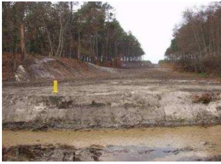
Situation en phase chantier
