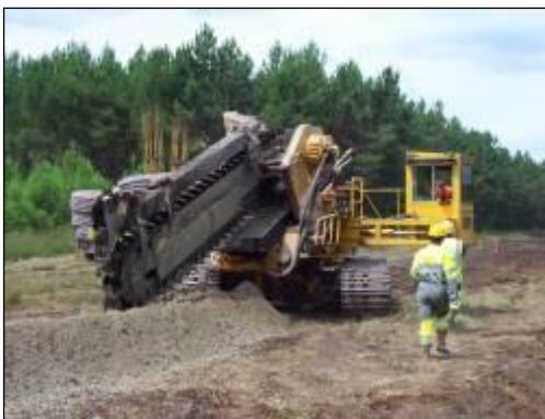
Figure 71 : Travaux de pose de la tranchée drainante et groupes de pompage
