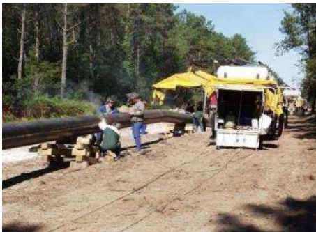
Soudage des tubes
