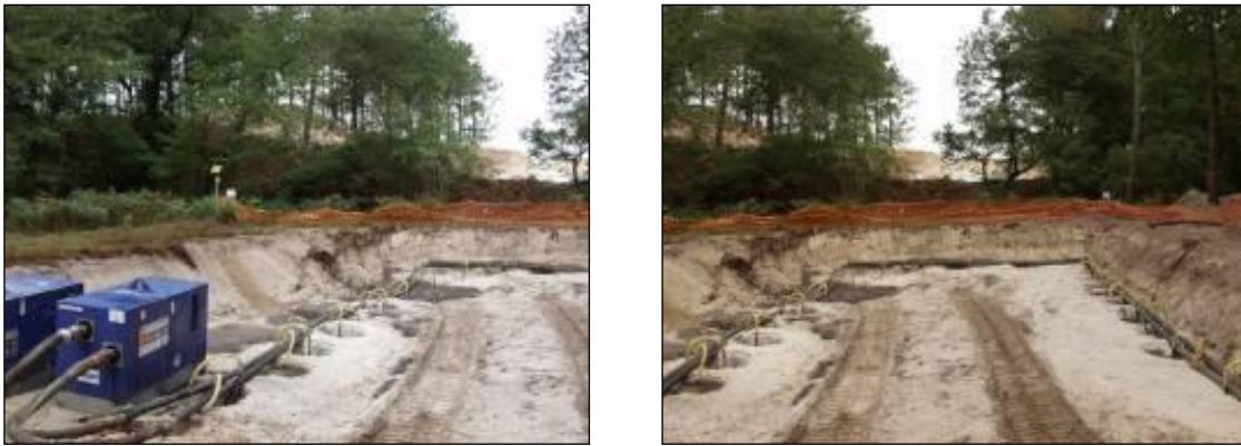
Figure 72 : Pompes et aiguilles filtrantes
