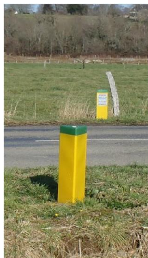
Figure 49 : Bornes utilisées pour une canalisation en arrêt d'exploitation définitif
