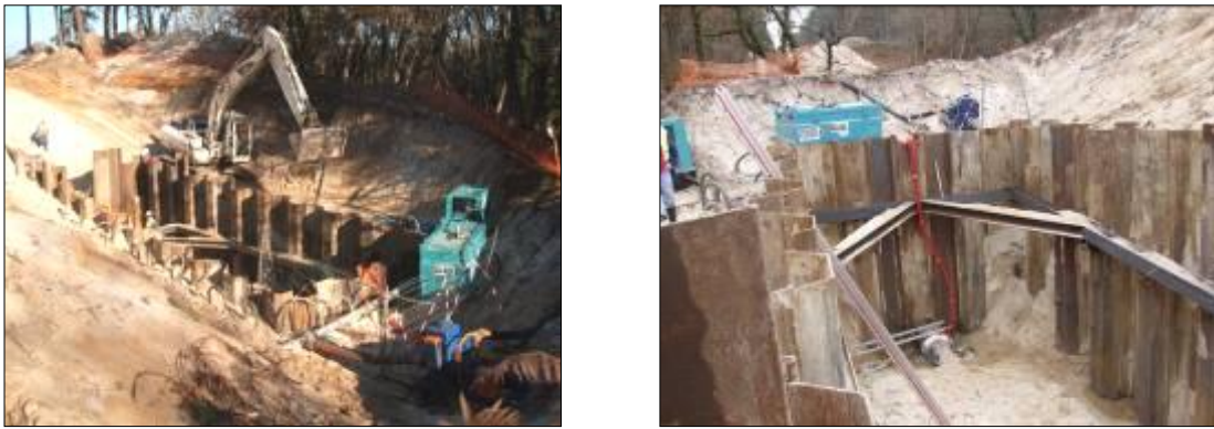
Figure 58 : Travaux de forage droit : exemple de niches d'entrée et de sortie
