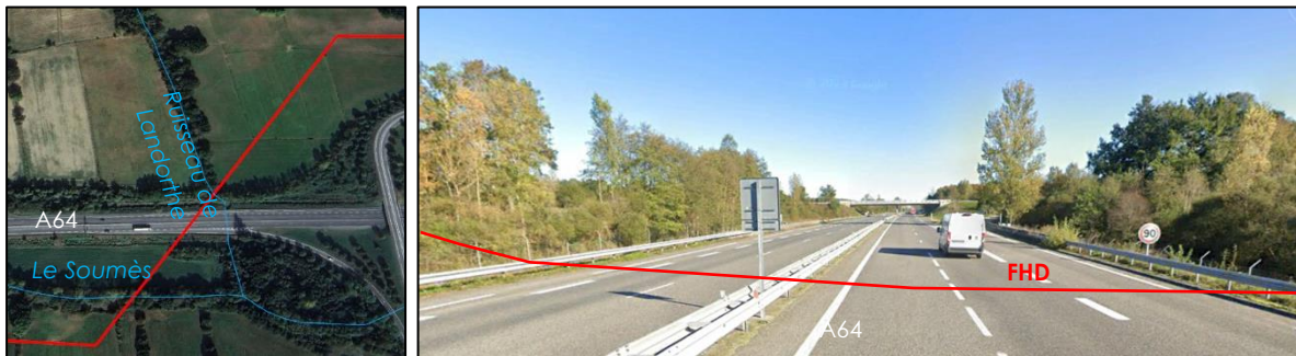
Figure 8 : Traversée de l'autoroute A64 en FHD à Saint-Gaudens/Landorthe
