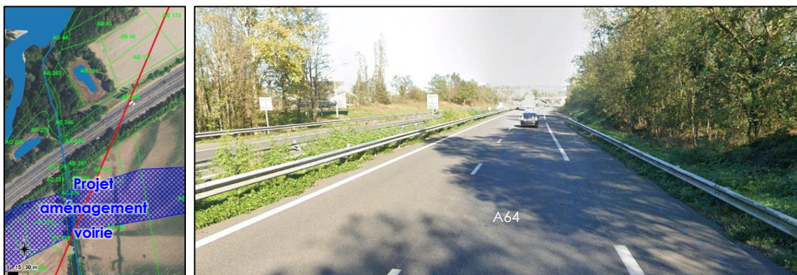
Figure 30 : Vue aérienne et photo de l'autoroute A64
