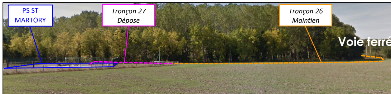
Figure 31 : Photo – Arrivée de la canalisation au poste de Saint-Martory
