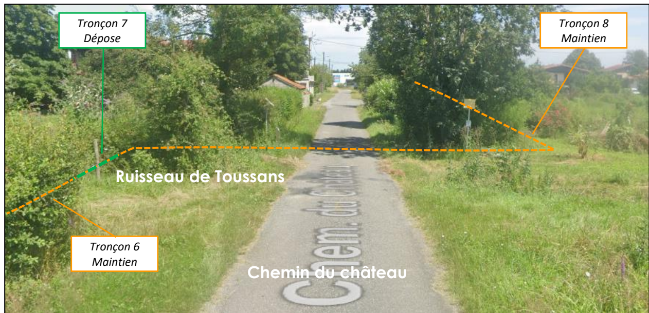
Figure 18 : Photo – Traversée du ruisseau de Toussans et du chemin du château
