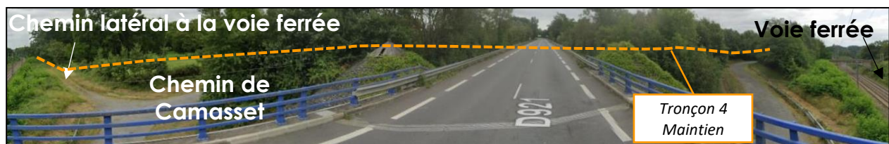
Figure 16 : Photo – Panorama depuis la RD921
