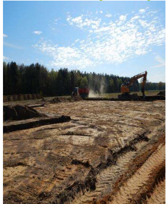
Nivellement du fond de forme, et création des pistes, virages et plateformes
