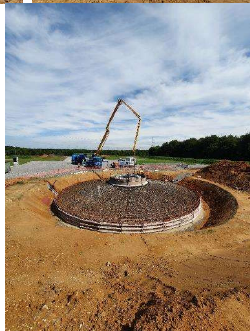
Ferrailage, coffrage et coulage
