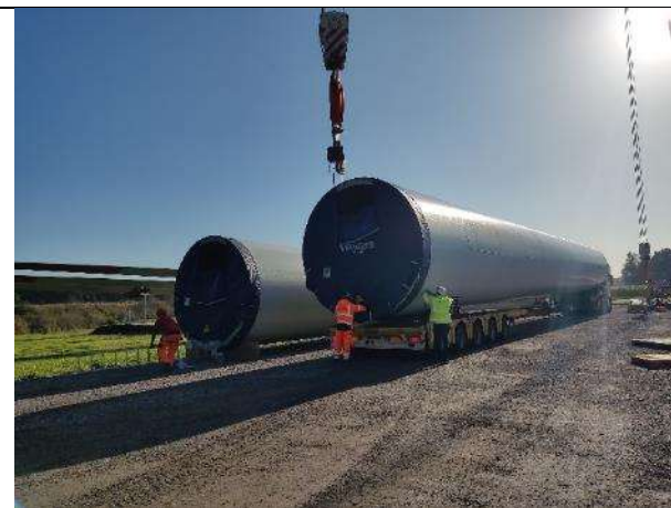
Nacelle, pales et segments de tour entreposés sur un chantier éolien
