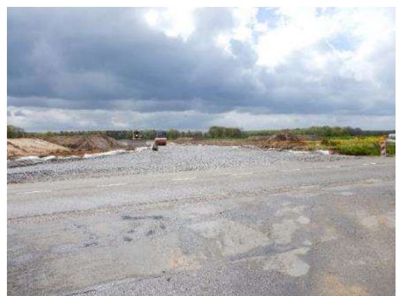
Suite Nivellement du fond de forme, et création des pistes, virages et plateformes
