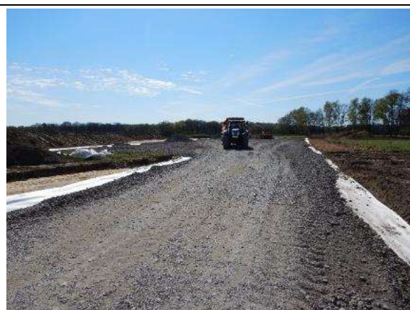
Suite Nivellement du fond de forme, et création des pistes, virages et plateformes
