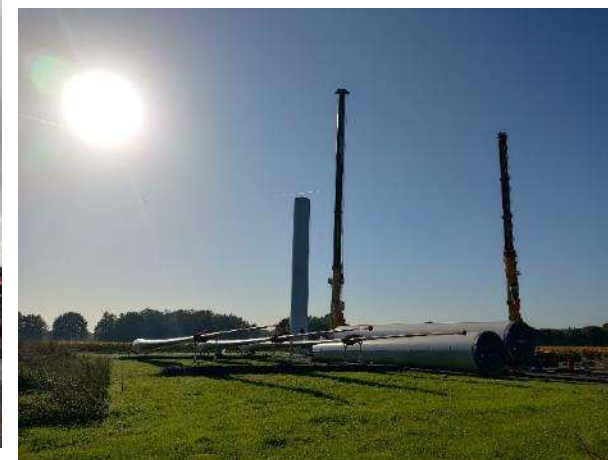
Pales entreposées sur un chantier éolien
