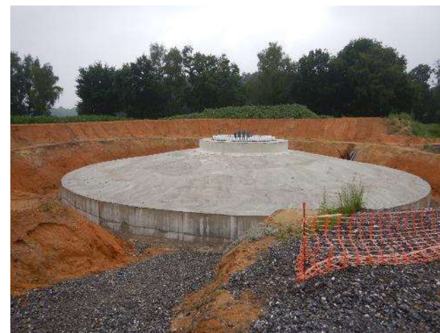
Coulage, finition de surface et décoffrage pour séchage
