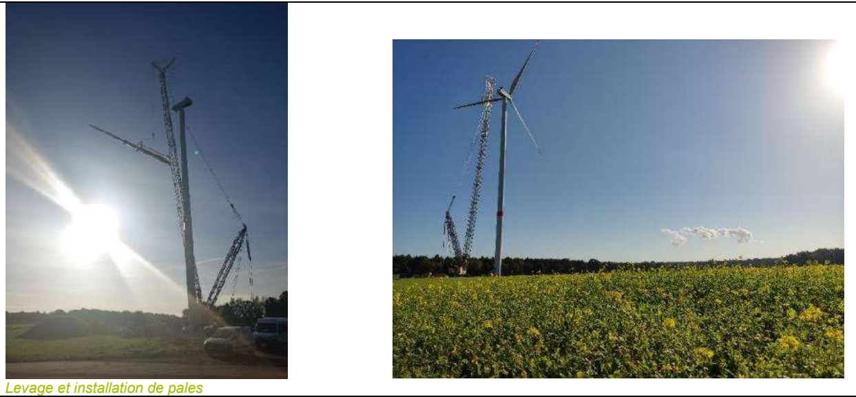
Levage et installation de pales
