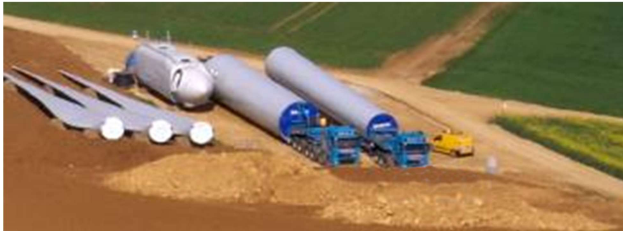
Figure 10 : zone de stockage temporaire centrale (source Vestas)
