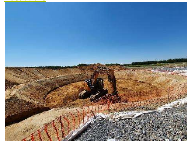
Excavations, préparation du fond de fouille et pose des gaines de passage des câbles
