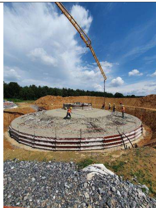
Coulage, finition de surface et décoffrage pour séchage
