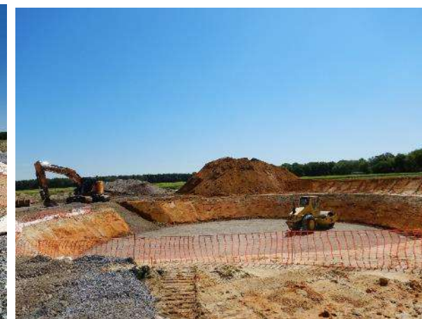
Excavations, préparation du fond de fouille et pose des gaines de passage des câbles
