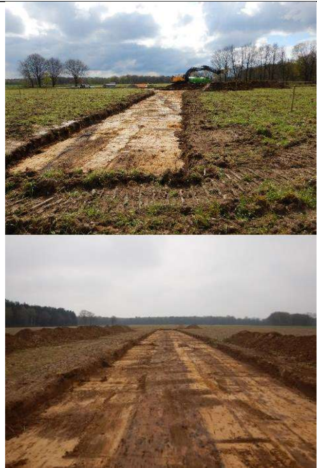
Photo 1 : Arasement des terres végétales et stockage
